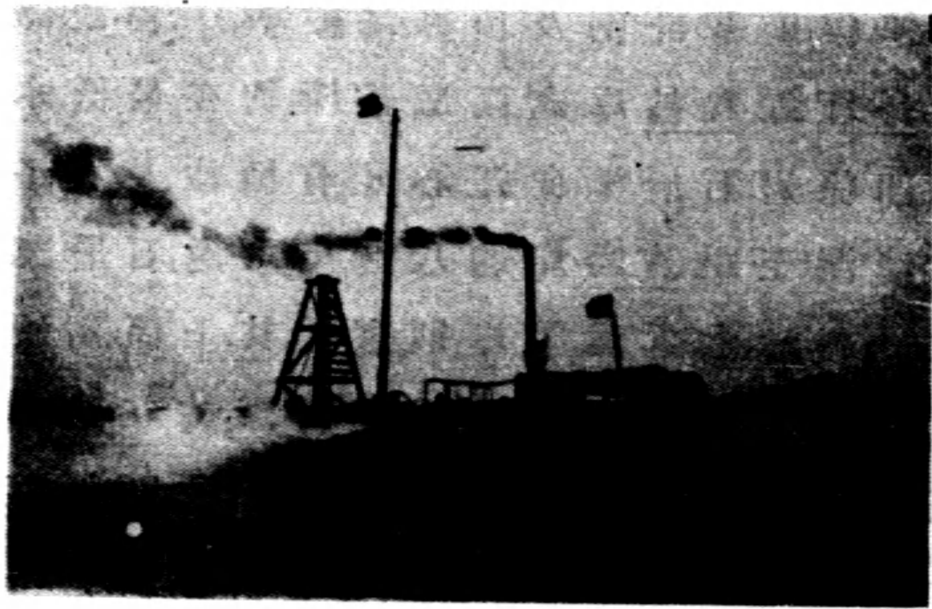
鑽探工事進行情形
