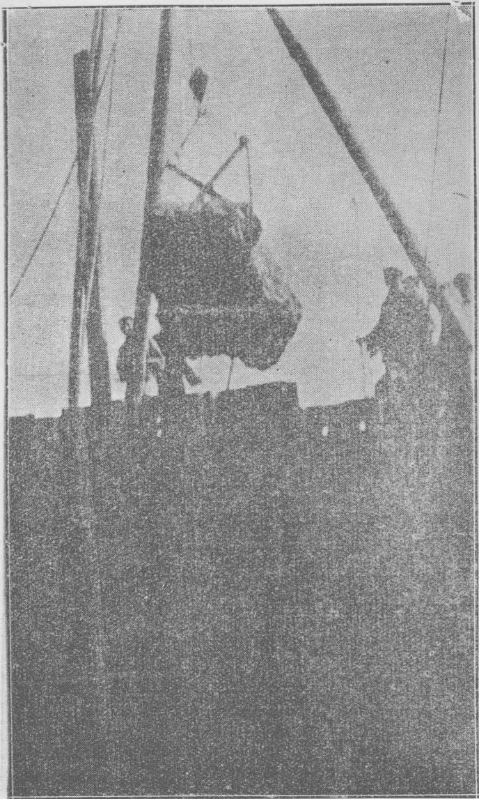
(七) 海底炸石施用起重機搬出時之情形
