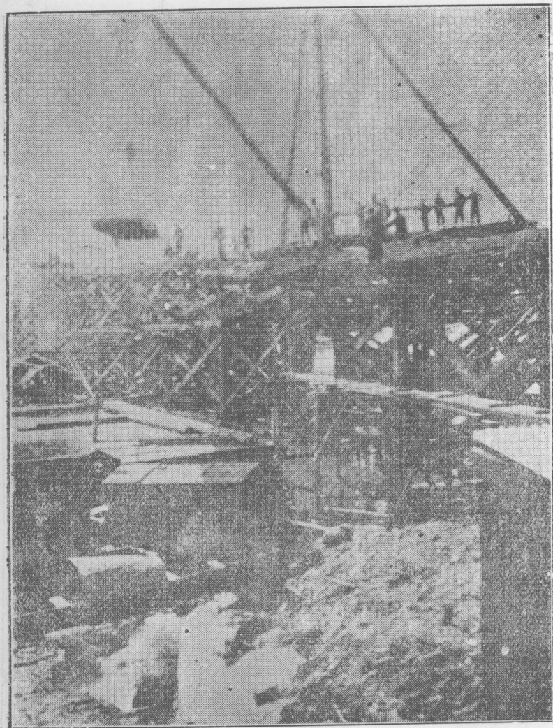
(十六) 安裝鐵橋時起運鋼樑鋼柱之情形
