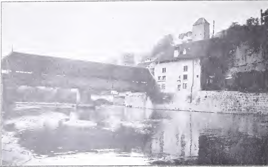
PONT COUVERT A FRIBOURG
