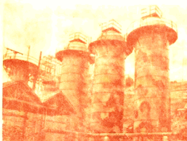
煉鐵爐（重排噸半日可全部煉鐵） 熱風爐（煉鐵爐內空氣經此增熱）
