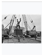
Id Verwoeste Stad Zadkine in Rotterdam laats beeld, hangend en , Bestanddeelnr 927-6844.jpg
