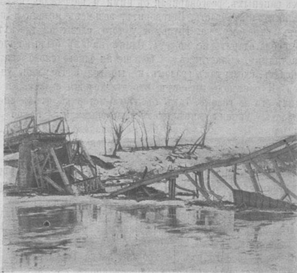
Мостъ въ Полѣсьи, разрушенный снарядами. (Фотоср. Д. Н. Логофета).
