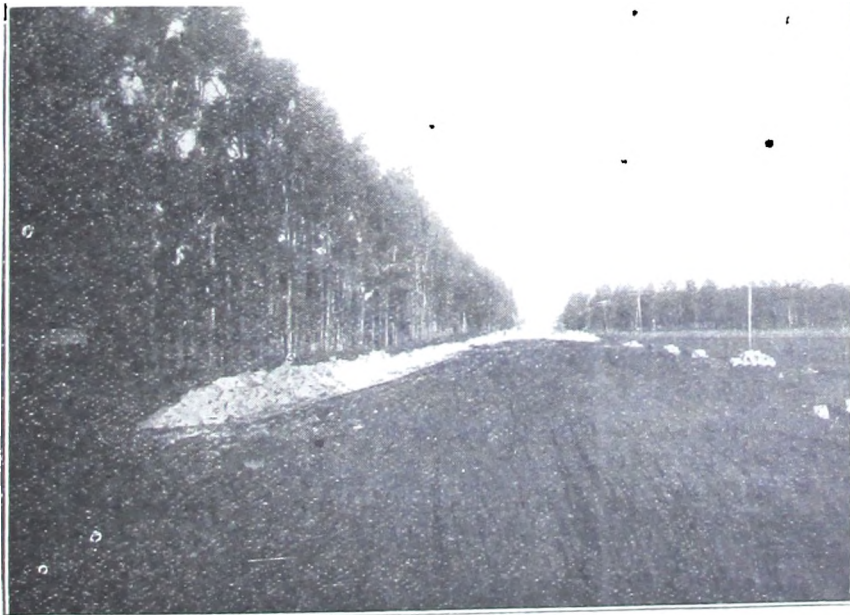
Trabajo de construcción de la Avenida Cincuentenario en Mar del Plata.
