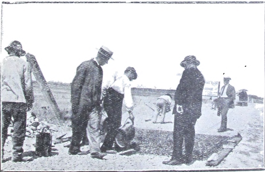
Otra vista del mismo ensayo.
