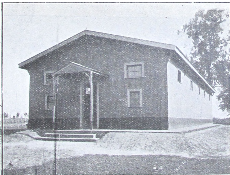
Construido el año 1924. Tipos de pabellones provisorios (zinc y forrado de madera), para atender las necesidades urgentes; capacidad para 60 enfermos. Construido por talleres de Hospital.
