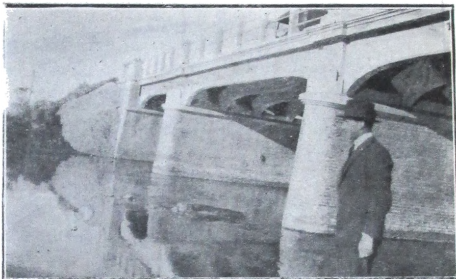
Vista lateral del puente "Pescado Castigado", en el camino de Juárez a Tres Arroyos. 1 tramos. Luz total, 40,00 ms. Ancho, 5,00. Material de construcción, mampostería y vigas P. N. Carga admitida, 500 kg. m.-2.
