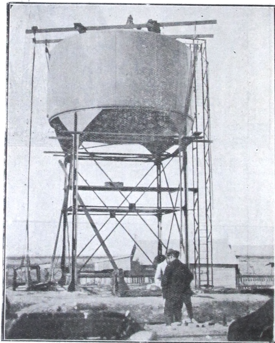
Tanque elevado de 100 metros cúbicos de capacidad en el Km. 86. Ramal de Beguerie al Azul.
