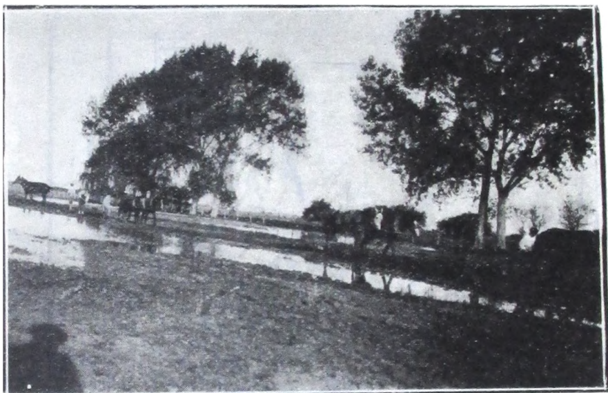
Reparación de pantano en el camino general de Luján a Rodríguez.
