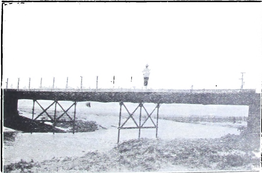
Puente "Austing" sobre el arroyo Tala en el camino general de San Pedro a Arrecifes, 3 tramos. Luz total, 30,00 ms. Ancho, 5,50 ms. Material de construcción, hierro.
