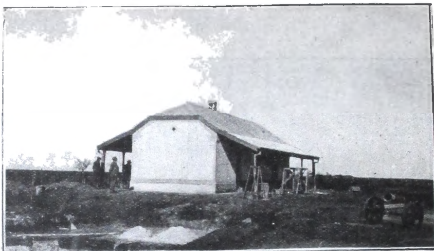
Casilla para cuadrillas de vía. — Km. 12. — Ramal de Beguerie al Azul.
