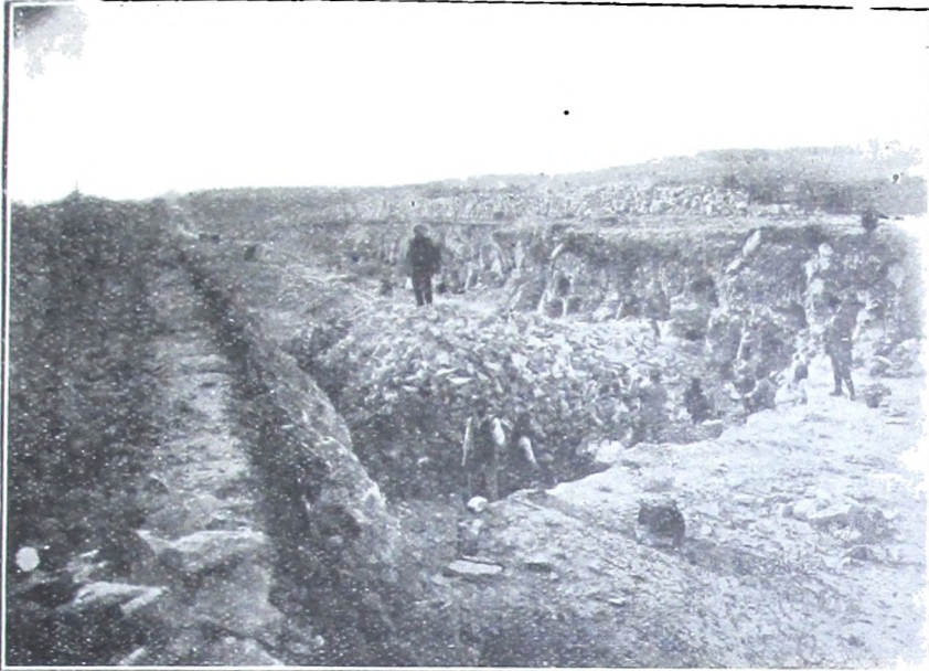
Desmante efectuado para la construcción de la Avenida Cincuentenario en Mar del Plata.
