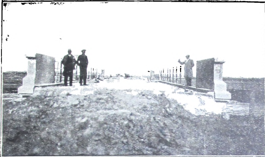
Calzada del puente "La María", sobre la cañada del Saladillo, en el camino Bragado a Lincoln.
