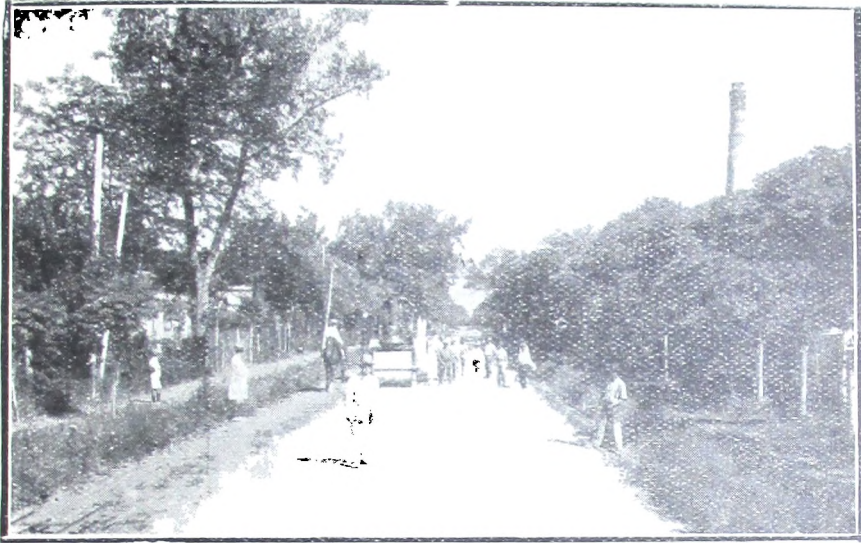
Vista del macadam en construcción en el camino de Bella Vista a San Miguel.— Partido de Gral. Sarmiento.
