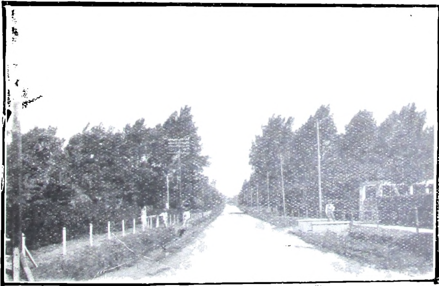
Trozo del mismo camino terminado.
