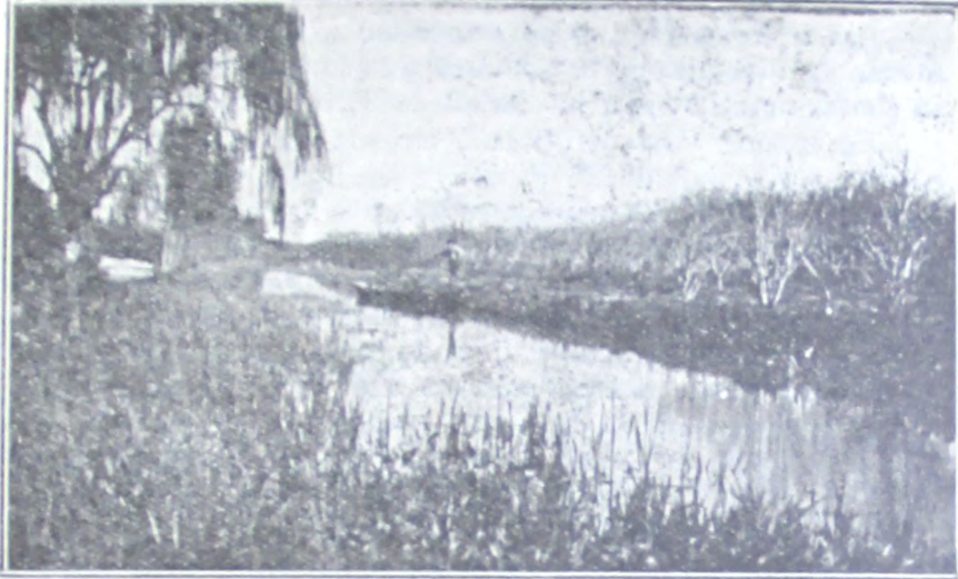
Tramo medio antes de la limpieza.
