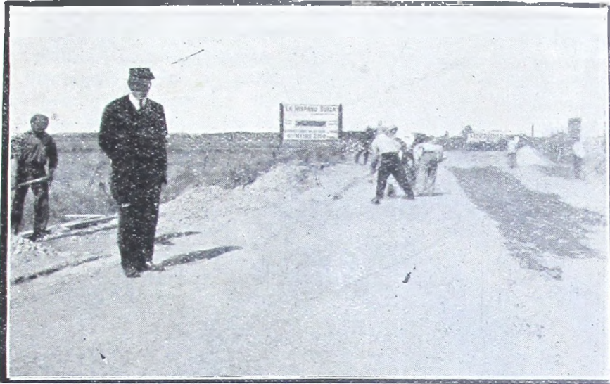
Ensayo macadam con cubierta de "Tarvia" en el camino de acceso a Quilmes.
