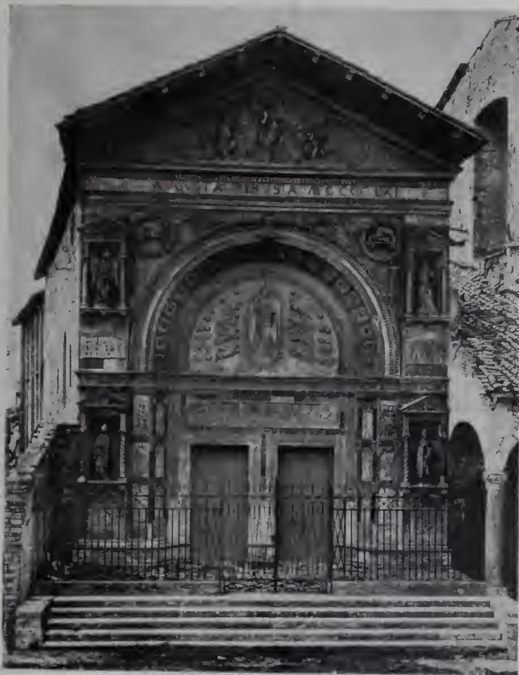
Fig. 252 — Perugia, San Bernardino, Agostino di Duccio: Facciata.
