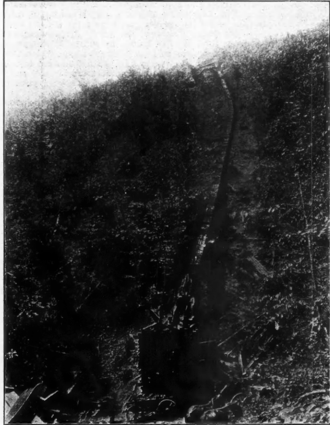
3.—DONALD MINE, VA., ORE CHUTE.
