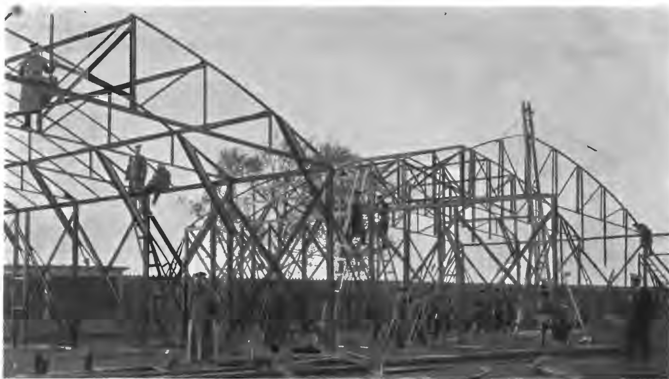
Разборные ангары, заготовленные на заводѣ Бессонъ въ Анжерѣ и построенные во время минувшаго „Праздника воздухоплаванія“ на аэродромѣ Т-ва „Крылья“ на Комендантскомъ полѣ. Сборка этихъ ангаровъ производится въ 24 часа; въ нихъ находился на Комендантскомъ полѣ аэропланъ „Блеріо“ лейтенанта Потровскаго.
