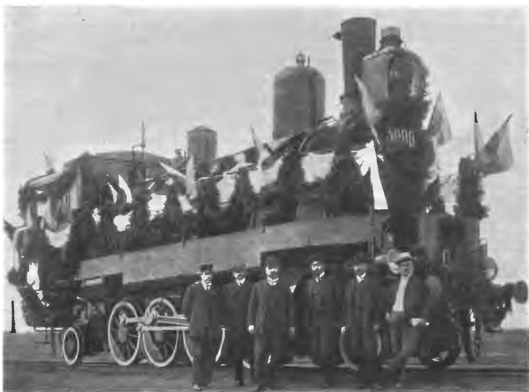
У паровоза стоятъ: Завѣдующій паровознымъ и механическимъ отдѣломъ Л. Яничъ, инженеръ Л. Шеленовъ, инженеръ Л. Фляновъ, инженеръ Кранковъ, мастера: Н. Занревскій и К. Рогойко.
