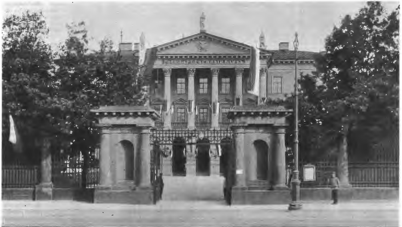
Фасадъ зданія банка по Садовой ул. въ С.-Петербургѣ. Къ 50-лѣтнему юбилею Государственнаго банка, 2 іюля с. г. По фот. К. Булга.
