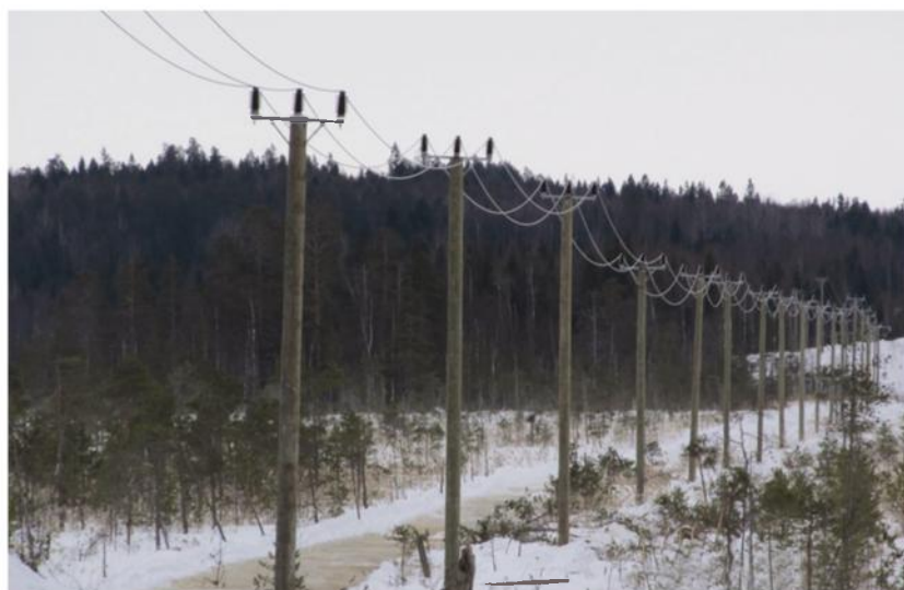
Новая линия электропередачи «Великая Губа-Жарниково»
