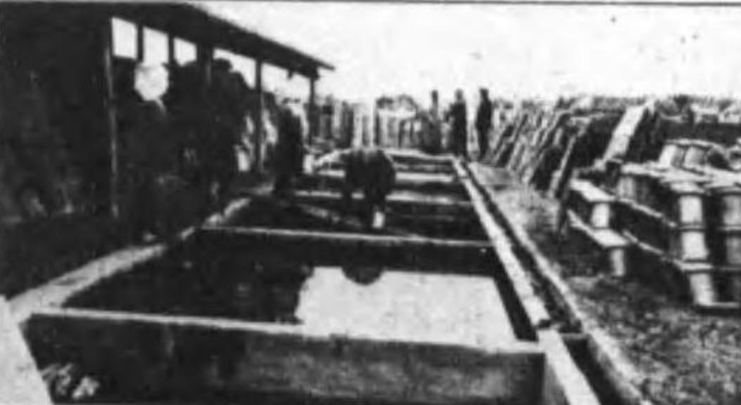
東山工業所工場の一部
