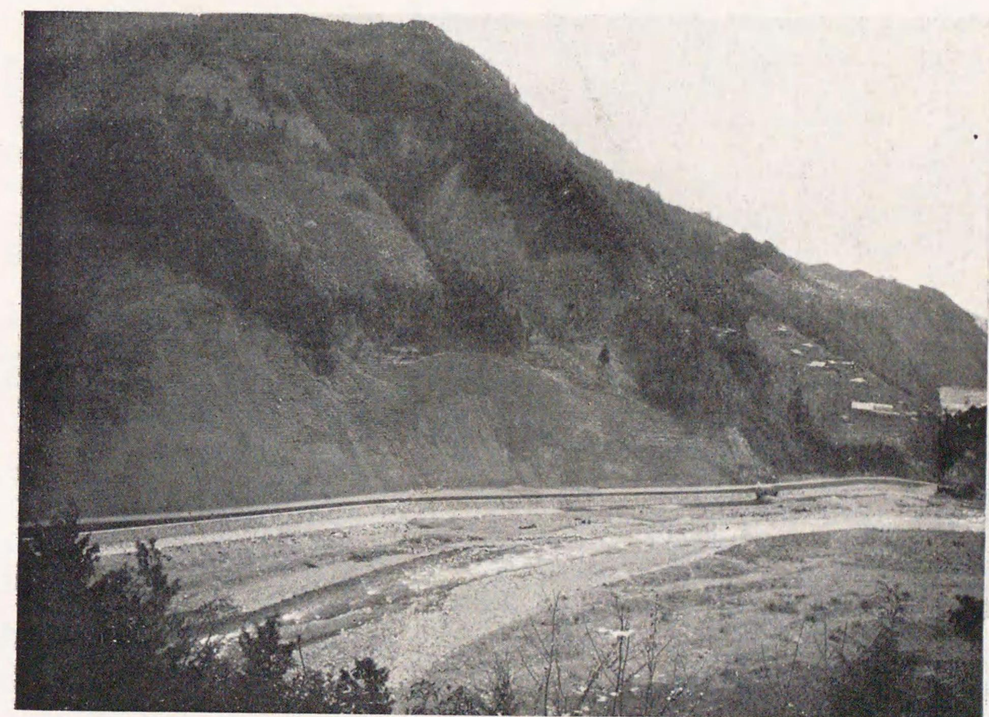
静岡縣安倍川本流同個所山腹及護岸工事施行の状況 (昭和八年)
