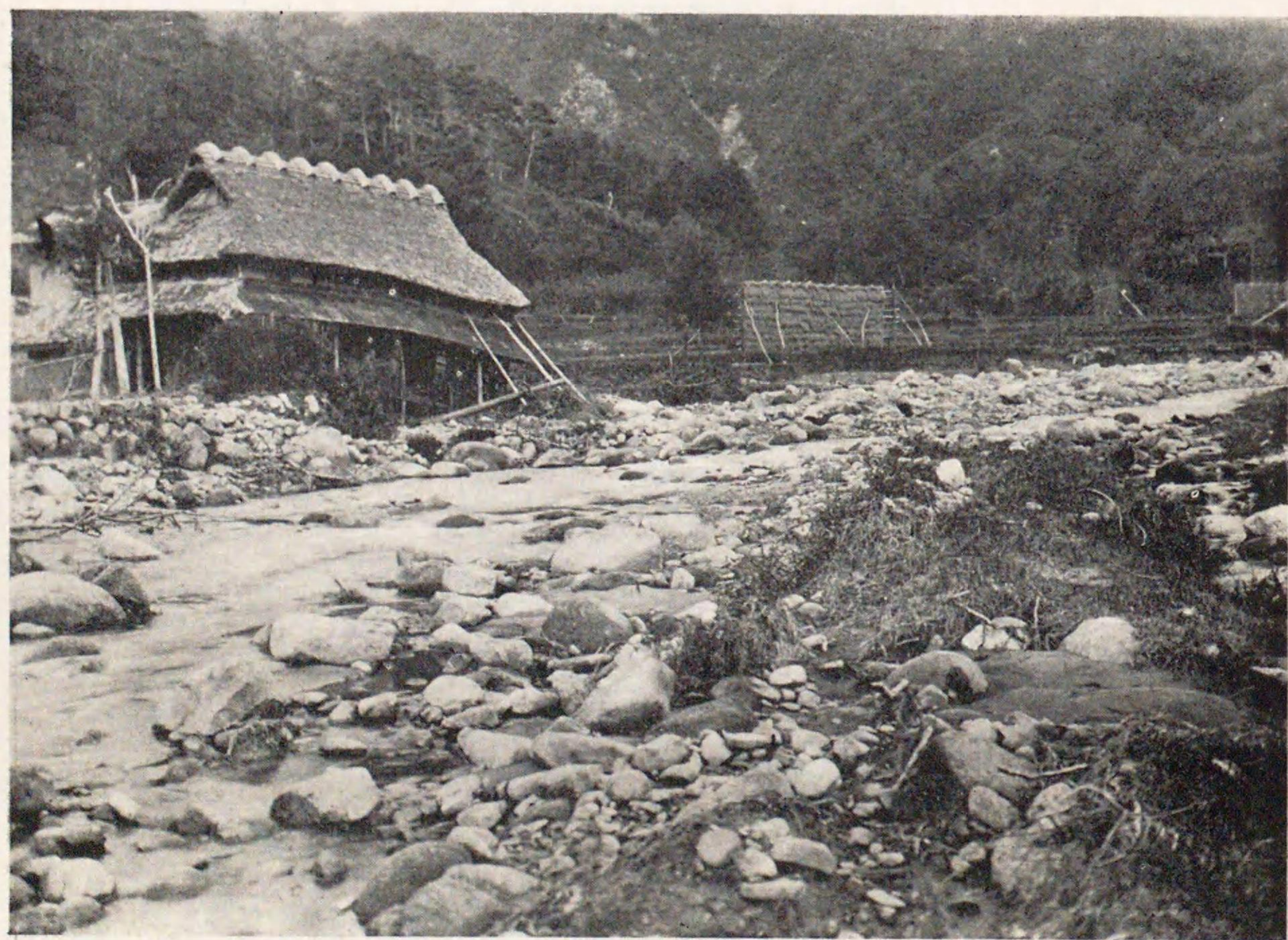
川上谷川 京都府熊野郡川上村字袋野小字柿本 家屋破損之狀況（昭和九年九月）
