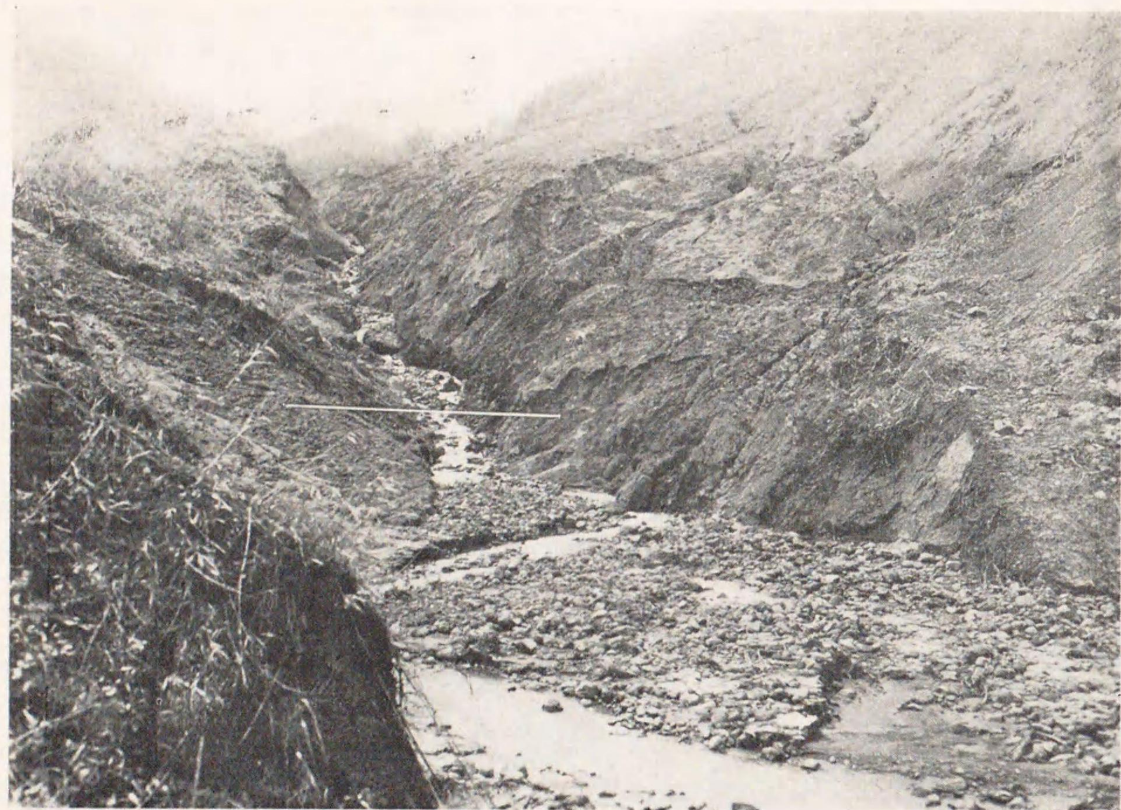
長野縣上水内郡小田切村犀川支流濁澤 施工前兩岸地滑りの狀況（昭和九年）
