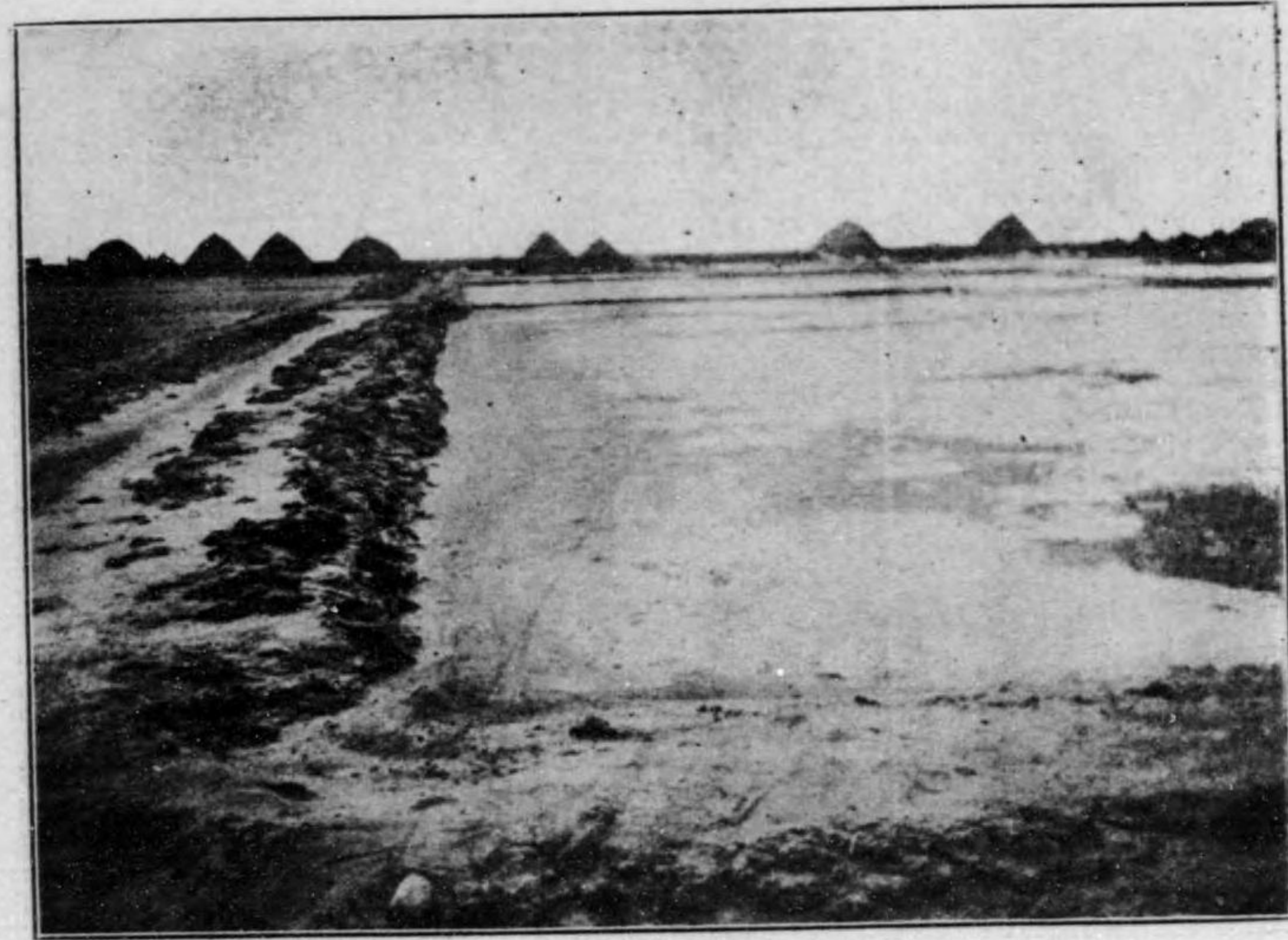
可崖鹽田 第一結晶池(普通蒸發=用フ)
