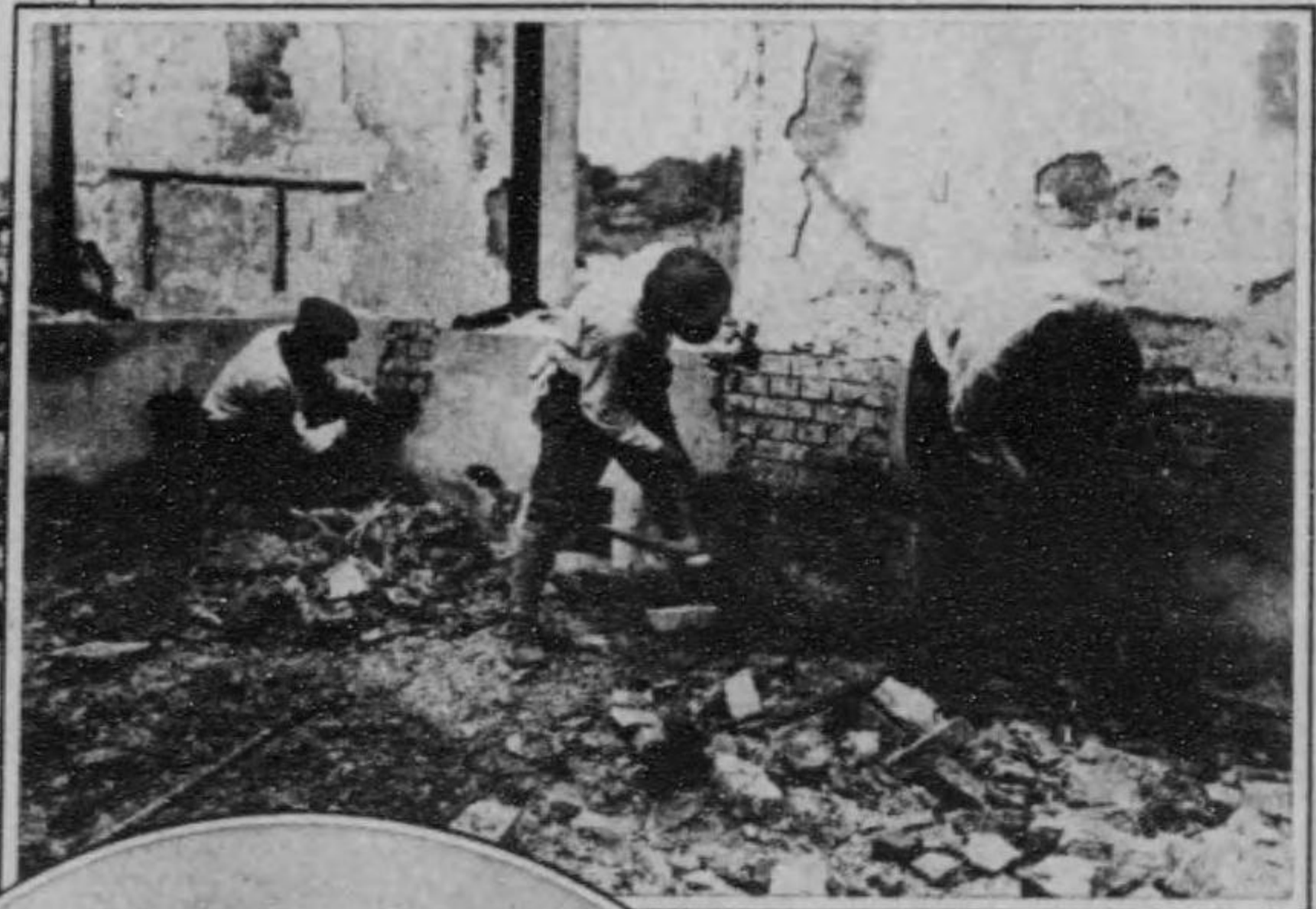
備壊破壊の省限大
