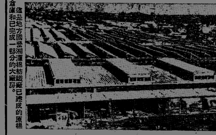
這是地方國營湘潭棉紡織廠已建成的廠房。
