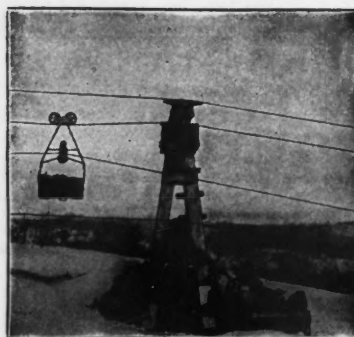
Bleichert Tramway of Ludwig Mond, Victoria Mines, Ontario, Canada.
