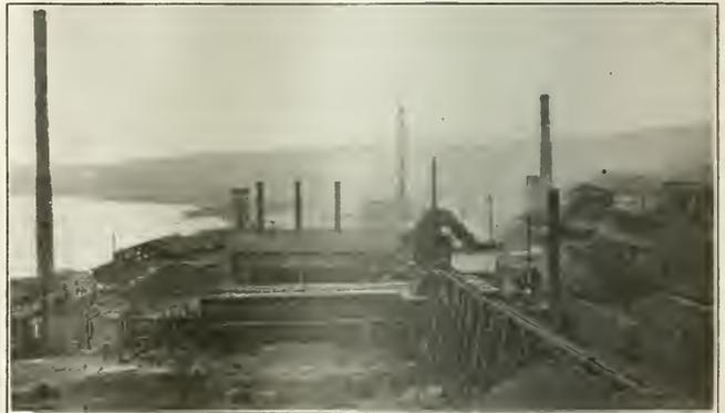
SMELTER AT CIA DE MINAS DE COBRE DE GATICO, CHILE. NEW COAL-FIRED REVERBERATORY IN FOREGROUND
