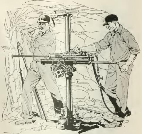
HAMMERING DRILL STEEL BREAKS THE STEEL AND THE DRILL
