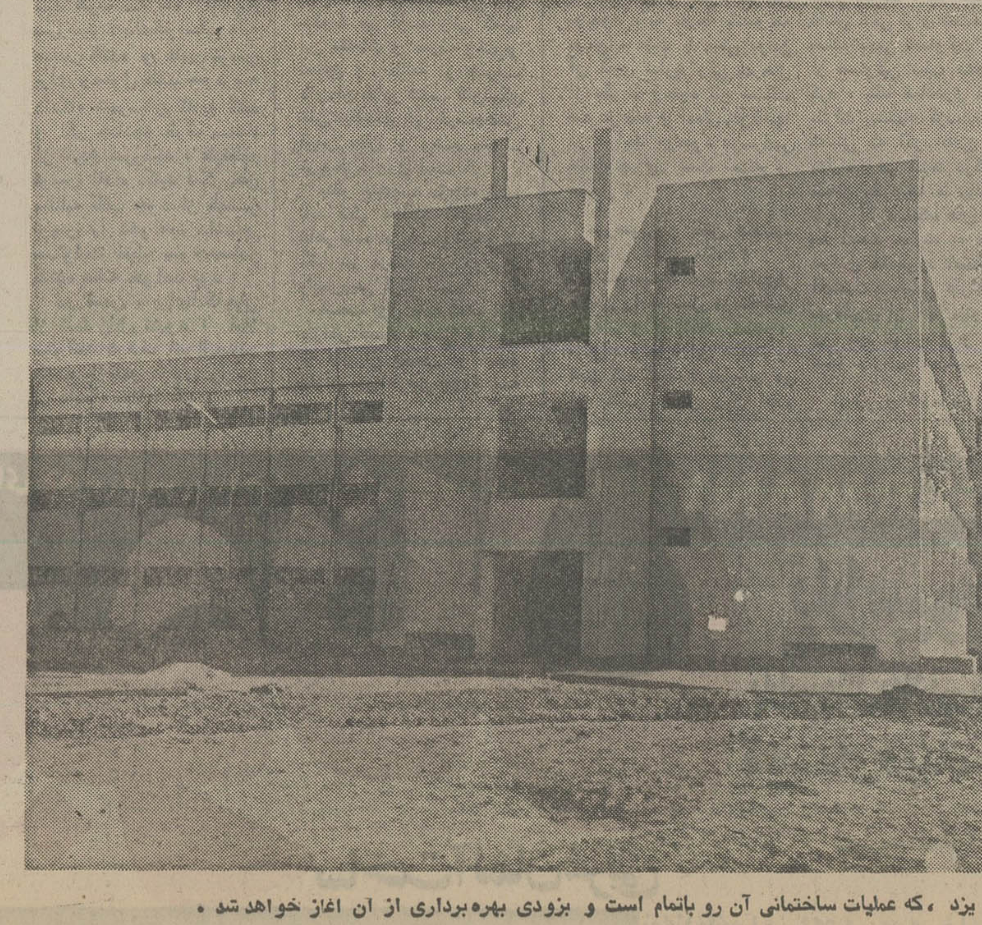
بیمارستان افشار یزد ، که عملیات ساختمانی آن رو پانام است و بزودی بهره برداری از آن آغاز خواهد شد .
