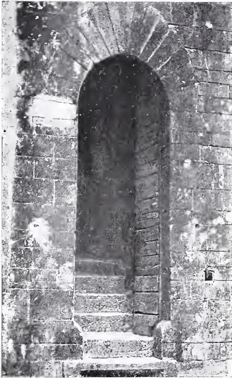
LA PORTA DETTA DEL MORTO IN UNA CASA DI VIA DEI CONSOLI.
