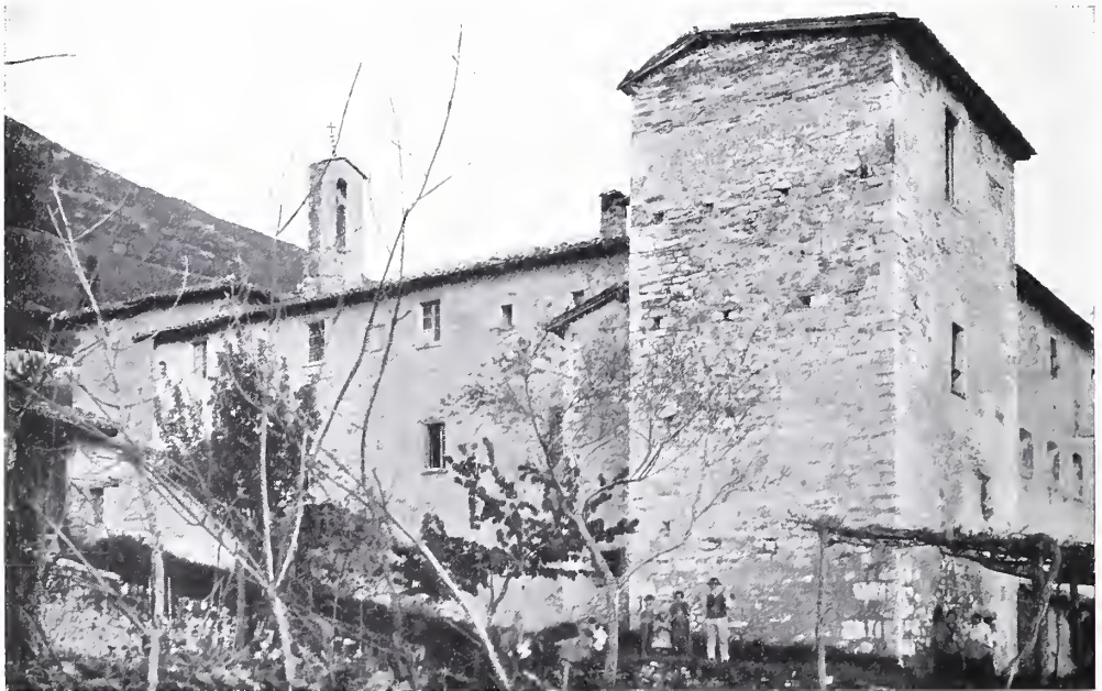
EX-CONVENTO DEI CAPPUCINI.
