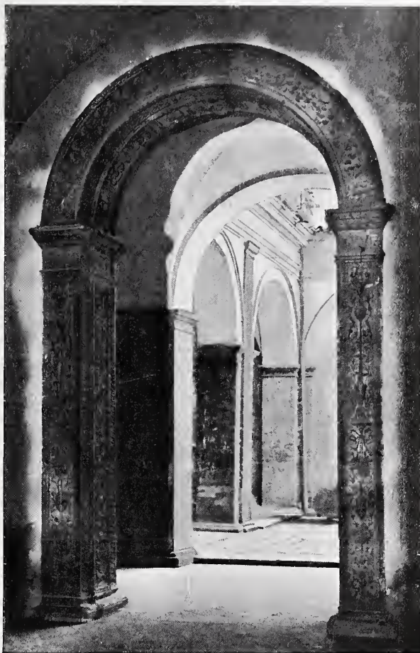
INGRESSO DEL PALAZZO ACCORAMBONI.
