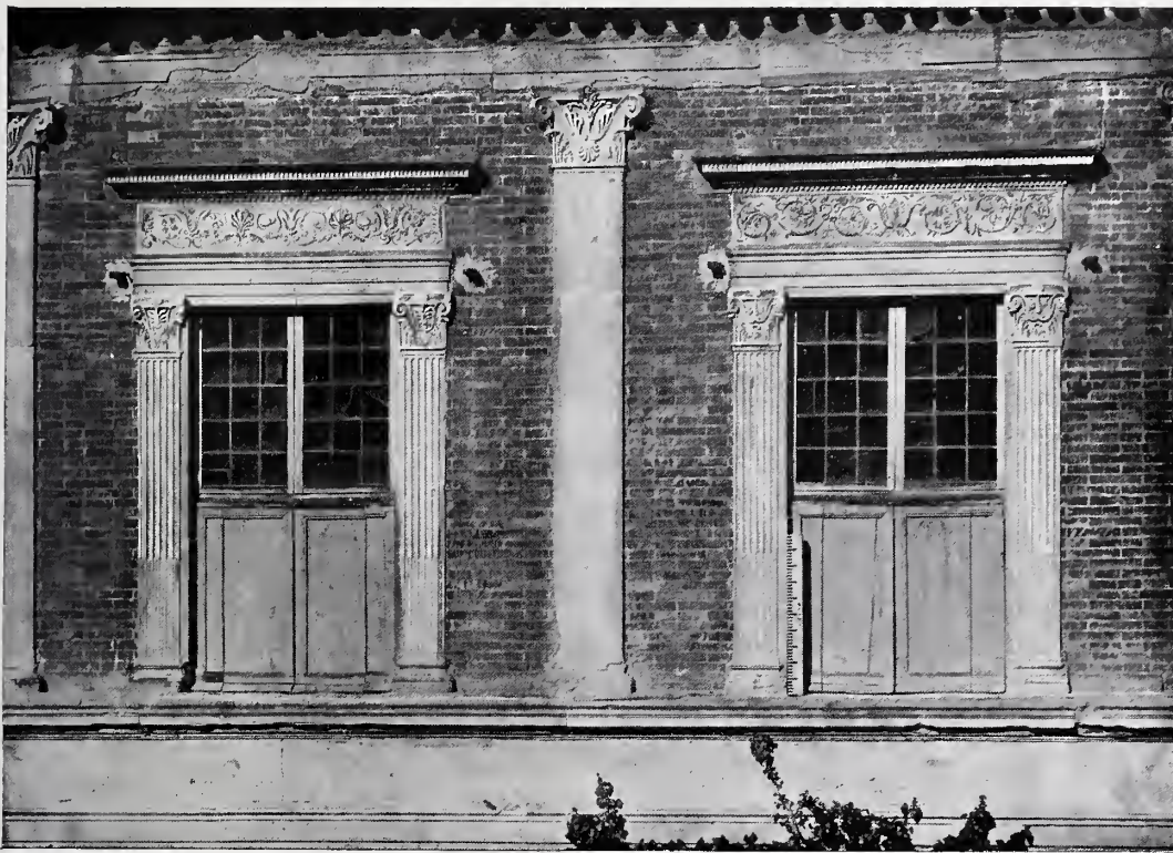
FINESTRE DELLA CORTE DEL PALAZZO DUCALE.
