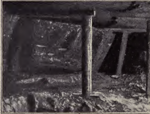
FIG. 109.—Undercut coal, fallen en masse.
