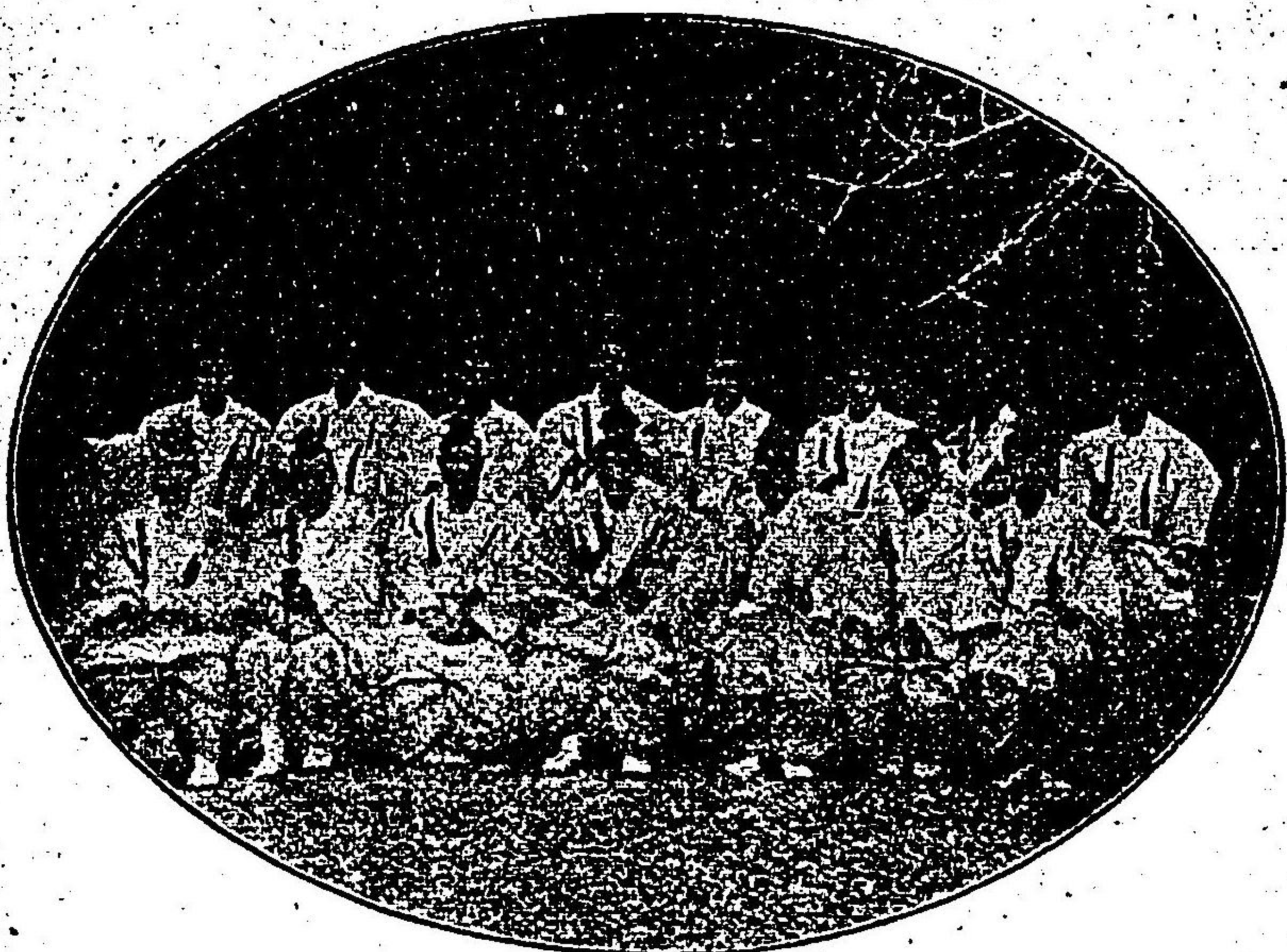
上棟祭奉仕外宮小工
