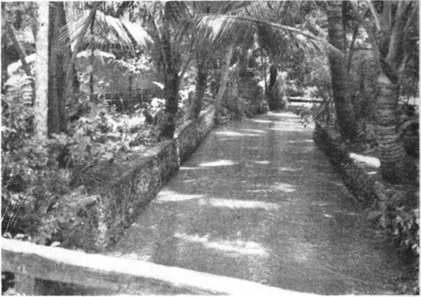
Untuk memperketijil kehilangan air maka serokan di desa Maleber, Kuningan, dibuat dari pasangan batu.
