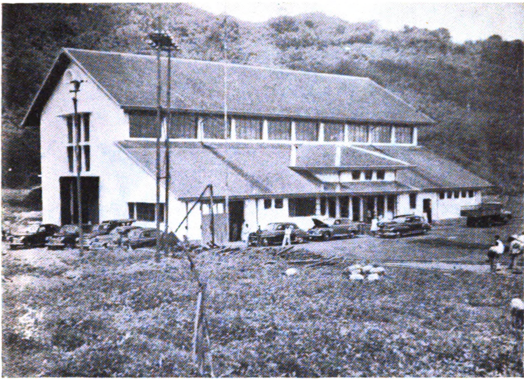
Sentral Listerik „Parakan Kondang” di Daerah Madjalengka, jang digerakkan oleh hasil bendungan-air kali Tjimanuk.
