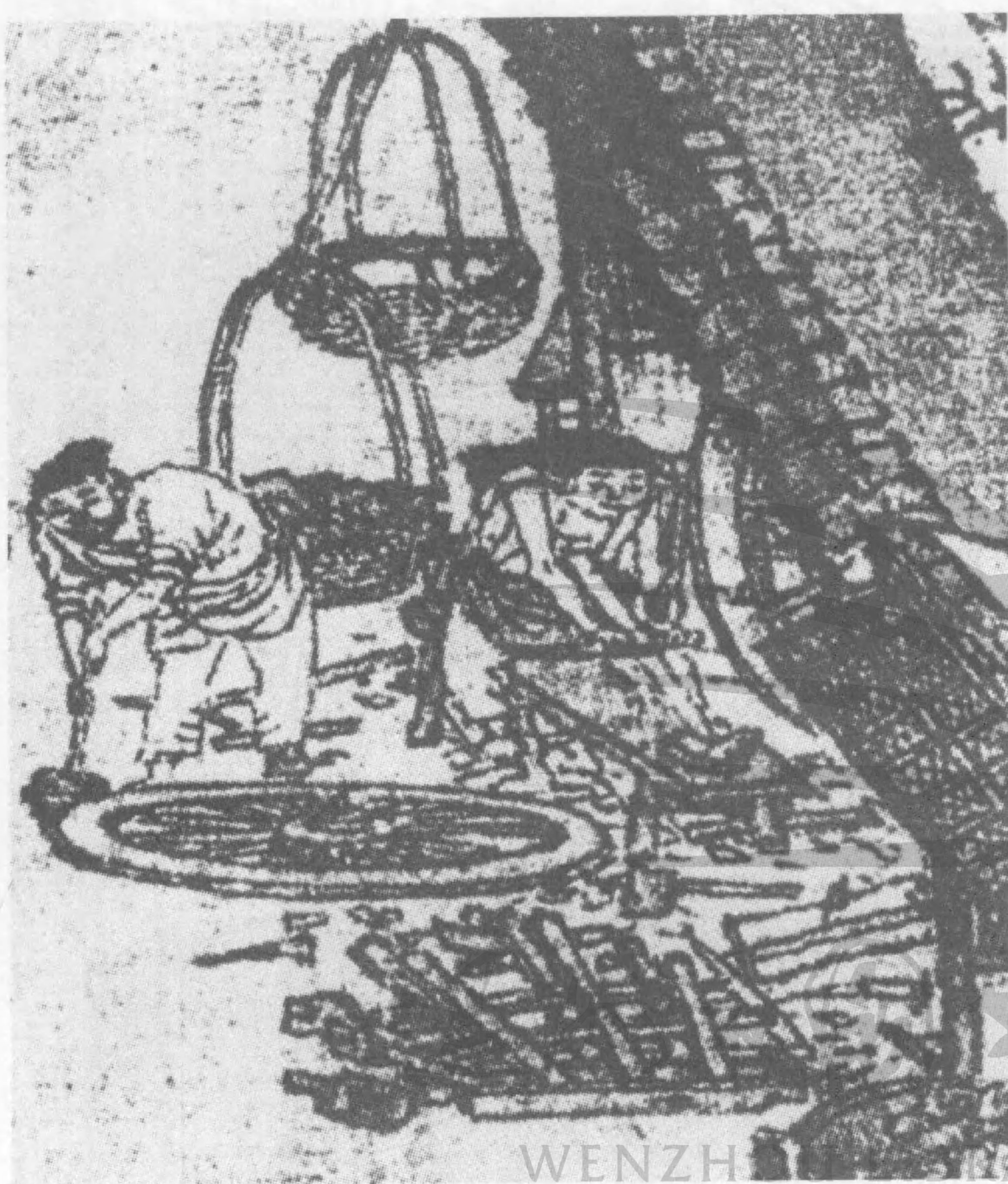
1-4 (宋)张择端《清明上河图》中的画面之一“制车作坊”，图中右下角有迄今所见最早的框锯形象。框锯的作用有三：一解材，二断料，三制榫。
