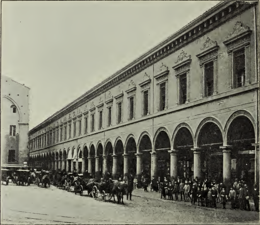
Abb. 102. Teil der Fassade des Archiginnasio (Pavaglione). Von Antonio Terribilia.
