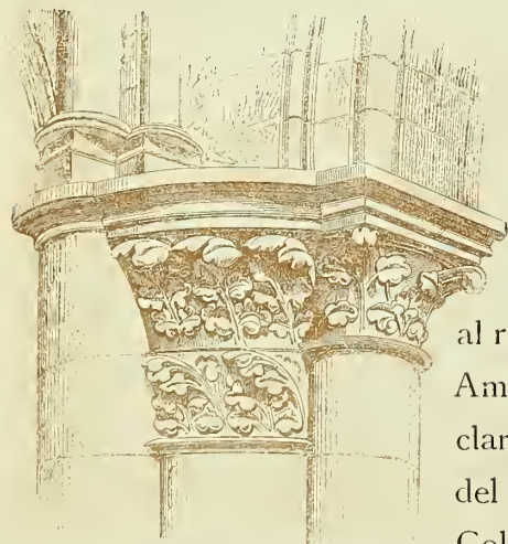
Fig. 1252. - CAPITEL DE LA ENTRADA DE LA NAVE DE LA CATEDRAL DE PARÍS
