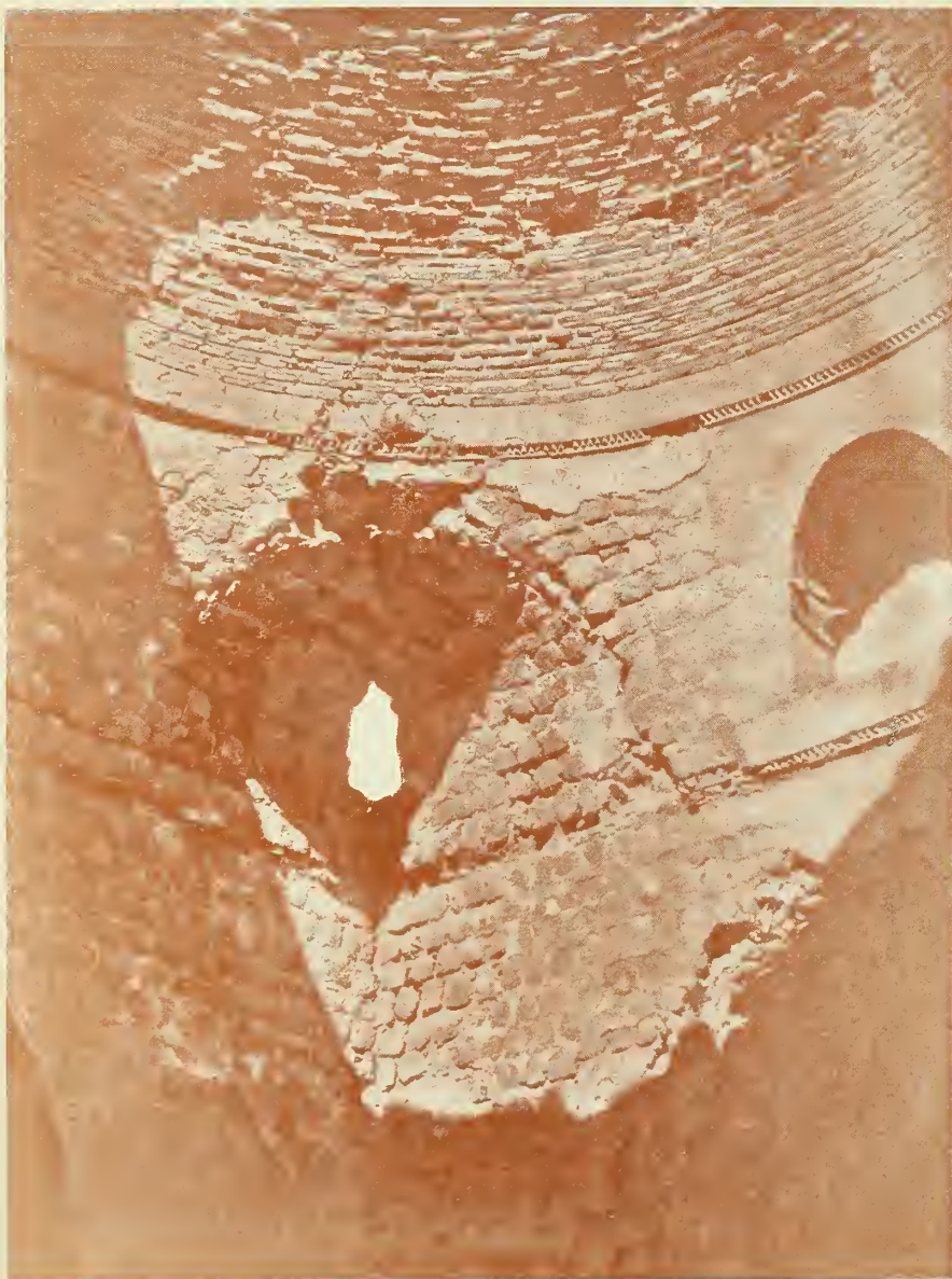
Fig. 674. - PALACIO DE SARVISTÁN (Trompa y bóveda vaída de la sala principal, según Dieulafoy, L'art antique de la Perse )
