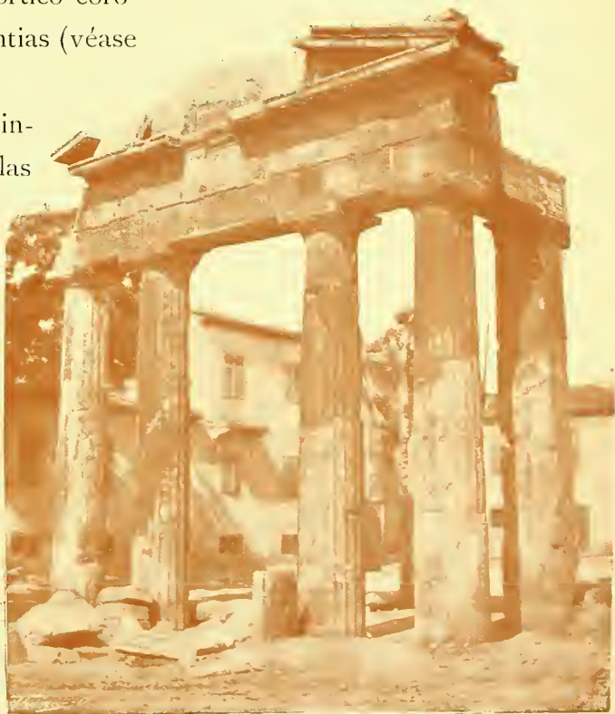
Fig. 419. — ENTRADA Á LA AGORA DE ATENAS, CONSTRUÍDA EN LA ÉPOCA DE AUGUSTO
