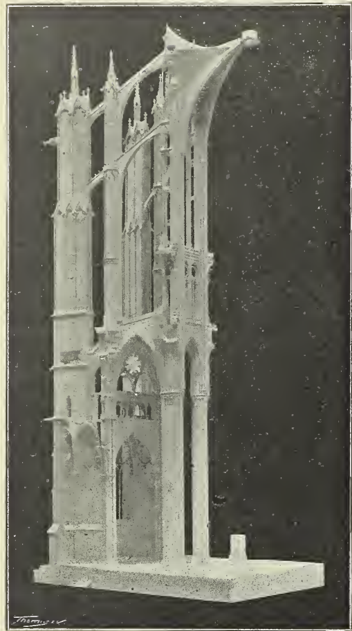
Fig. 1235.-ESTRUCTURA DE ÁBSIDE DE LA CATEDRAL DE BEAUVAIS (MUSEO DEL TROCADERO)
