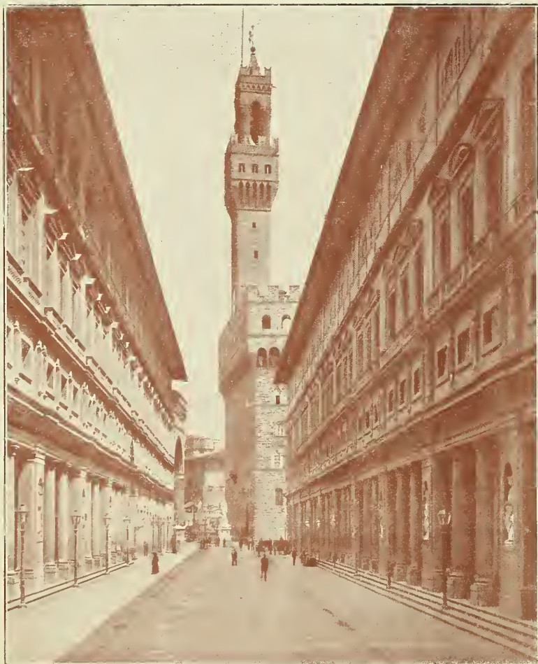
Fig. 1414. — PÓRTICOS DE LOS OFICIOS EN FLORENCIA
