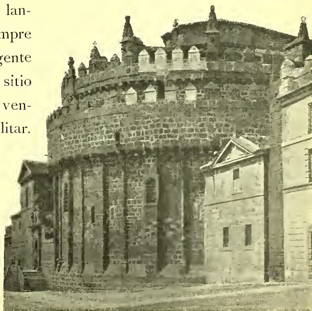
Fig. 1129. — ÁBSIDE DE LA IGLESIA CATEDRAL DE ÁVILA CORONADO DE ALMENAS Y MATACANES DE PIEDRA
