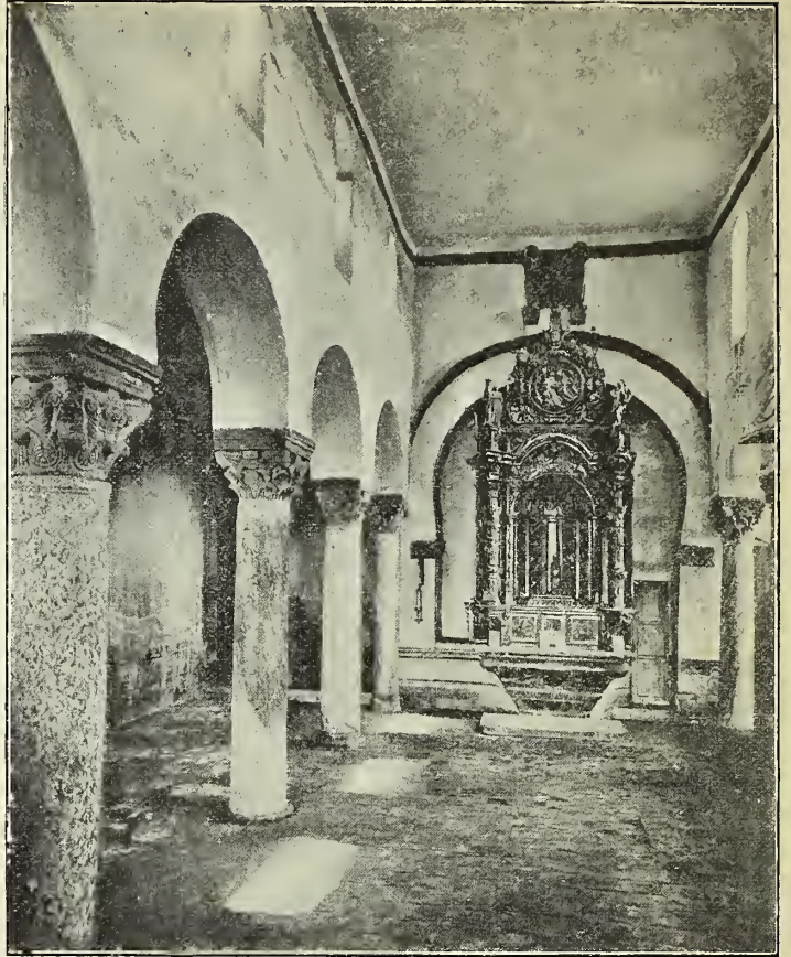
Fig. 666. — INTERIOR DE LA IGLESIA DE SAN JUAN BAUTISTA EN BAÑOS
