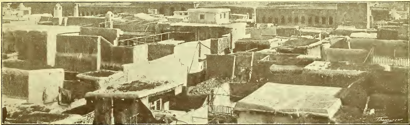
Fig. 173. - DAMASCO. - CUBIERTAS DE TIERRA CONSTRUÍDAS SIGUIENDO EL SISTEMA REPRESENTADO EN LAS TUMBAS LICIAS
