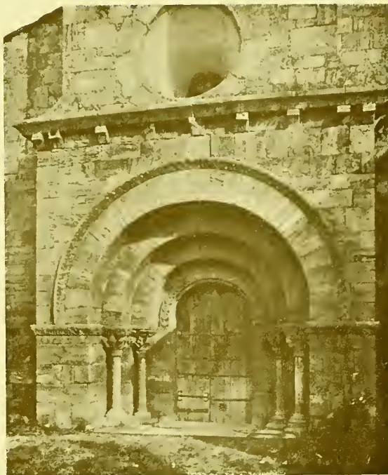
Fig. 967. - IGLESIA DE PORQUERAS (CATALUÑA)
