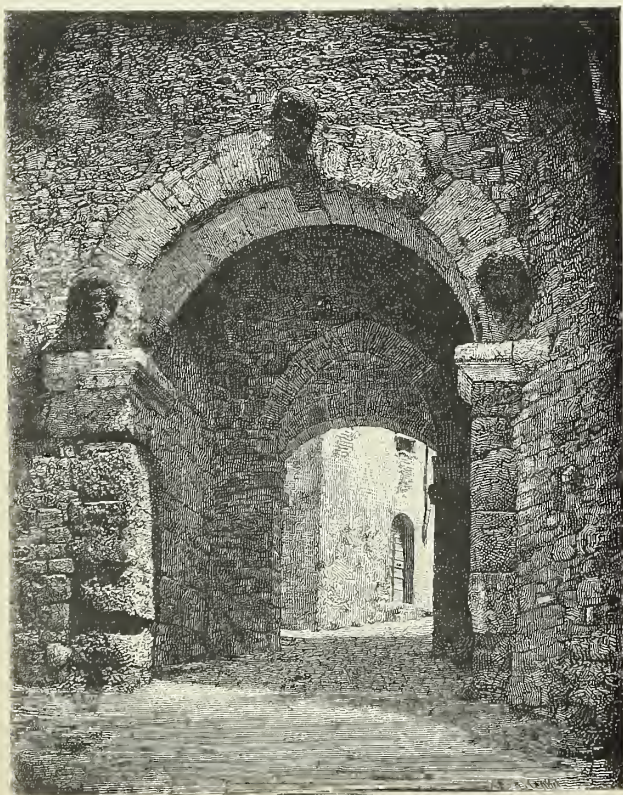
Fig. 435. - «PORTA DELL'ARCO» EN VOLTERRA
