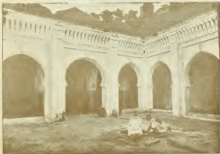
Fig. 867. - PATIO DE LA MEZQUITA DE SIDI-EL-HALUNI EN TREMECÉN
