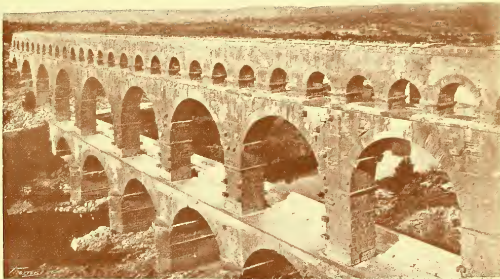
Fig. 488. — ACUEDUCTO DE GARD (situado á 27 kilómetros de Nimes)
