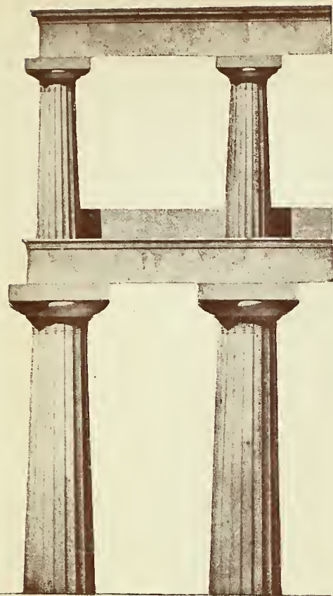
Fig. 379.-SUPERPOSICIÓN DE ÓRDENES EN LA NAOS DEL TEMPLO DE POSEIDON EN PAESTUM. (1/100)
