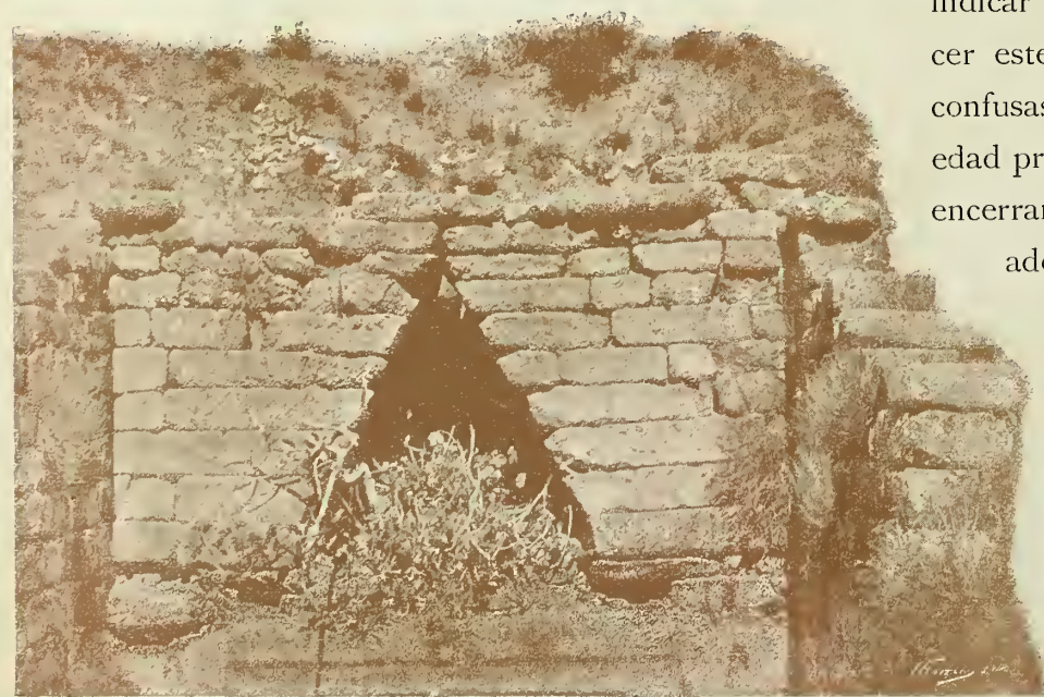
Fig. 257. - «TESORO DE ATREO,» DETALLE DEL DINTEL Y DEL SISTEMA DE DESCARGA DEL MISMO
