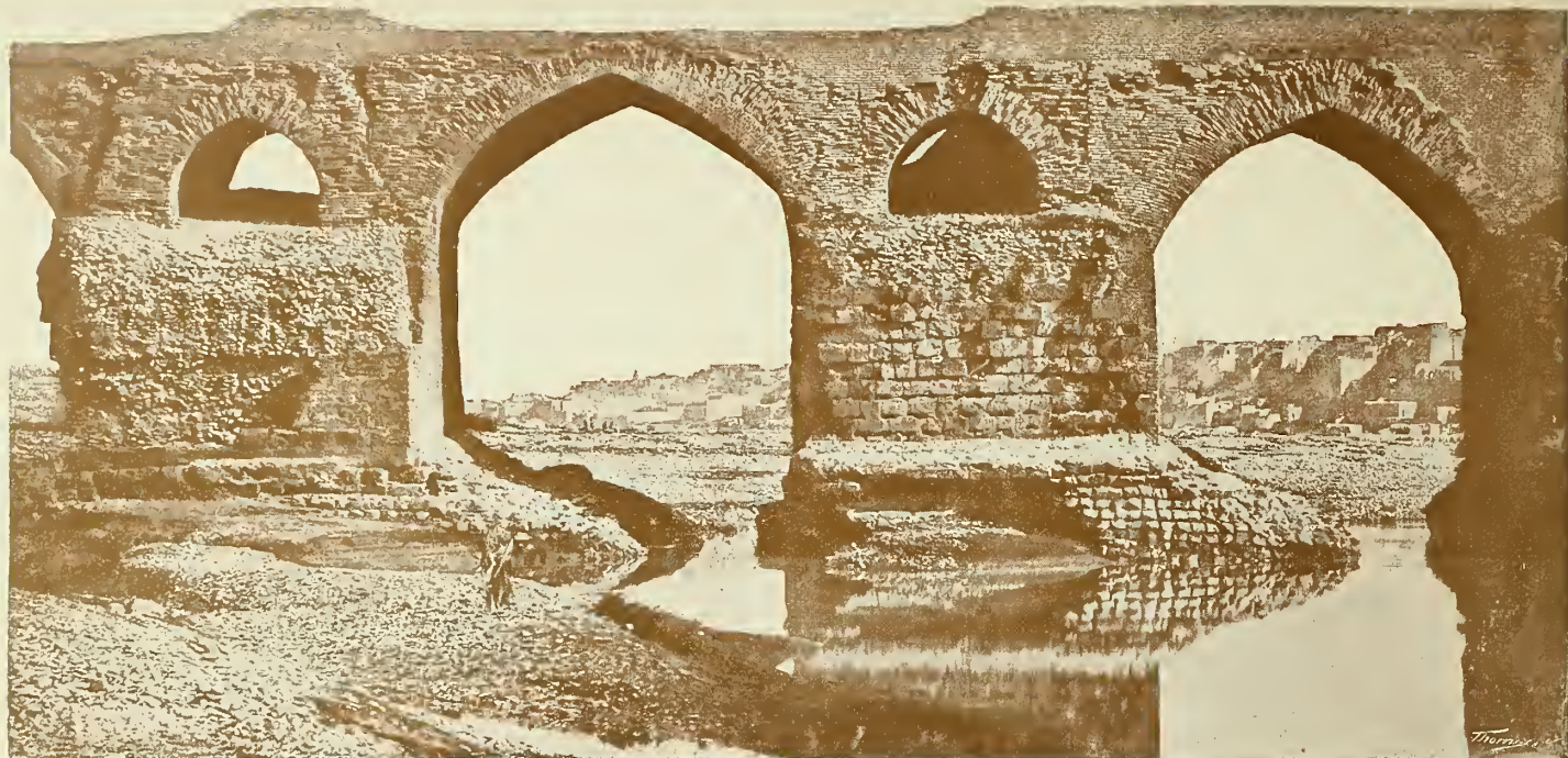
Fig. 936. - PUENTE DE DISFUL
