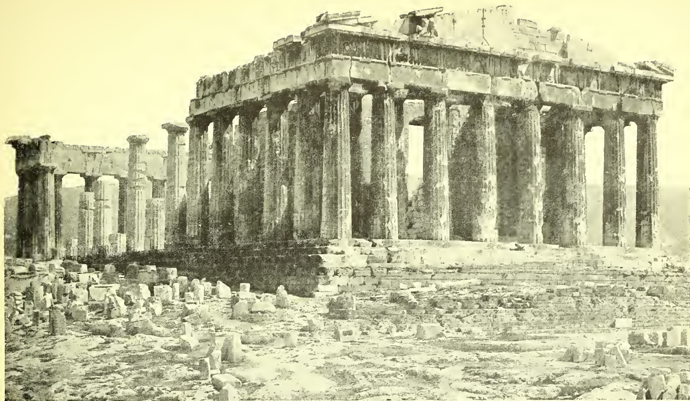
Fig. 229.-ESTADO ACTUAL DEL PARTENÓN DE ATENAS
