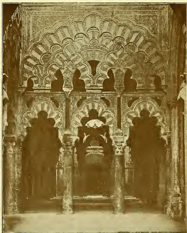
Fig. 789. - ARCOS QUE SE CRUZAN FRENTE LA CAPILLA DEL MIRAB EN LA MEZQUITA DE CÓRDORA
