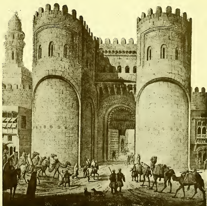
Fig. 937. — PUERTA DE BAB-EL-FUTUH EN EL CAIRO
