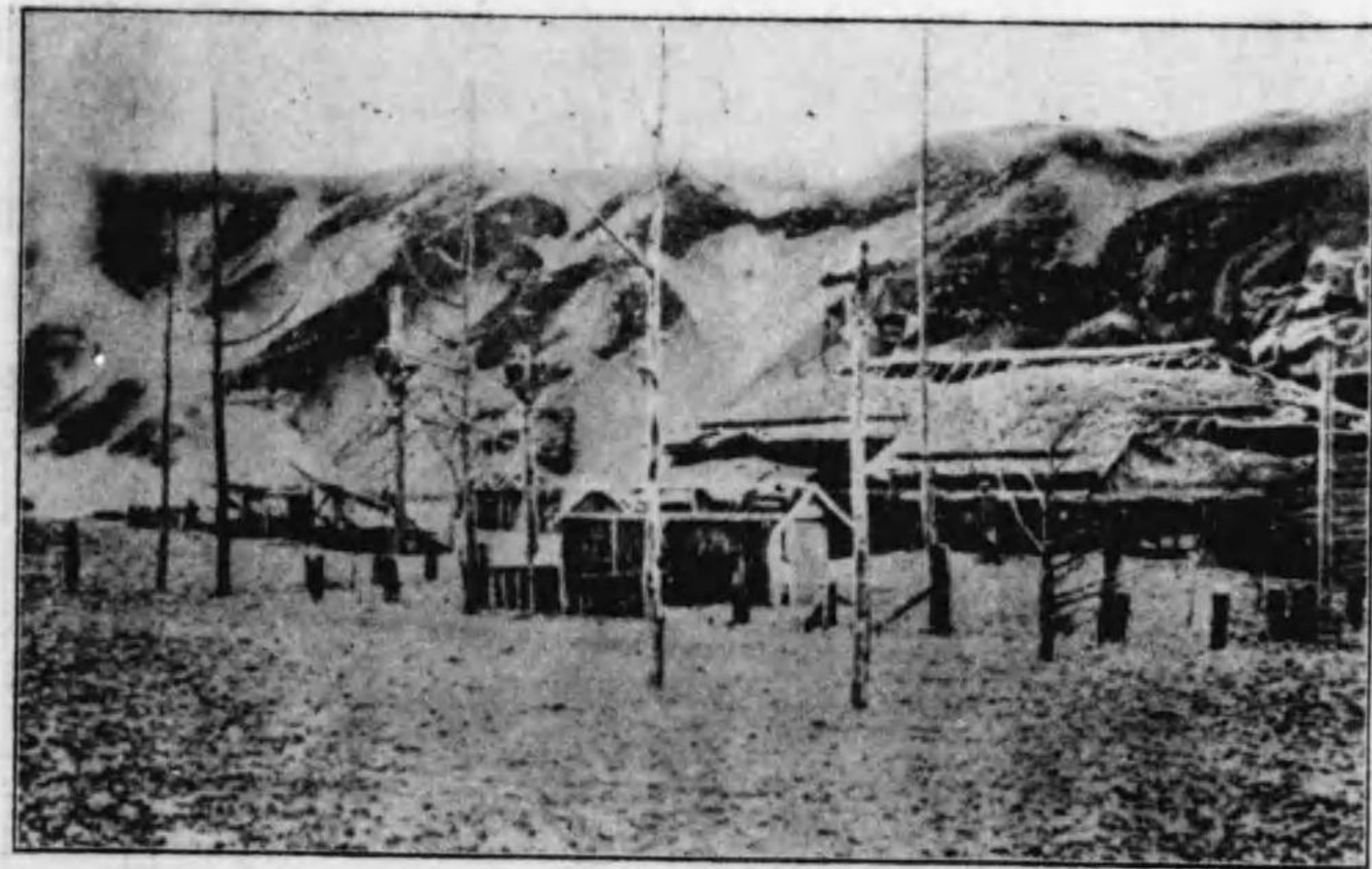
鹿部村の被害家屋
