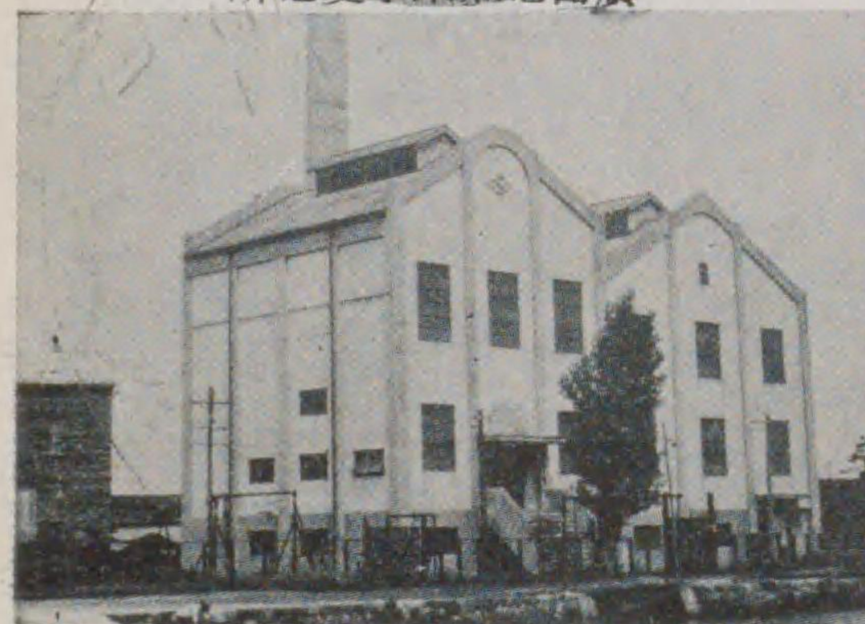
所電發力火氣電島廣
