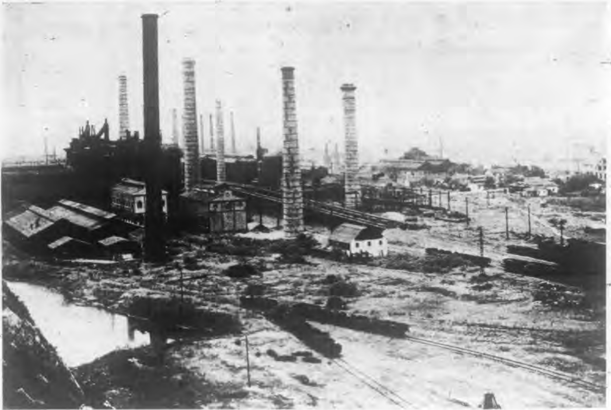
漢 陽 鐵 工 廠 之 一 角
