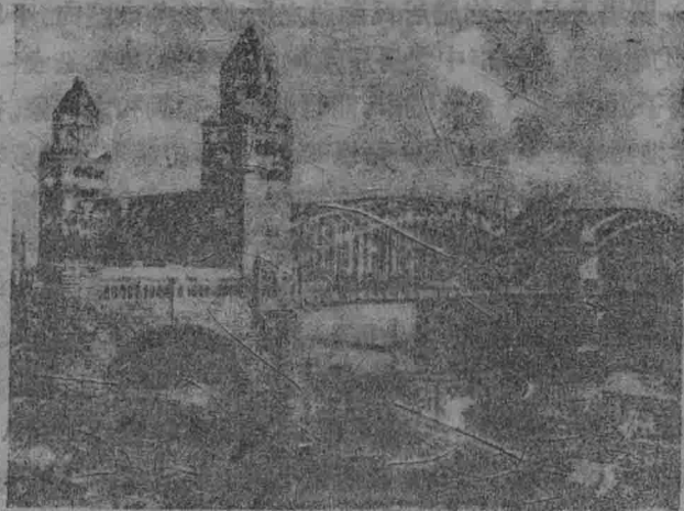
第二五三圖 哥羅約(Cologne)之荷爾登連橋(Hohenzollern Bridge)
