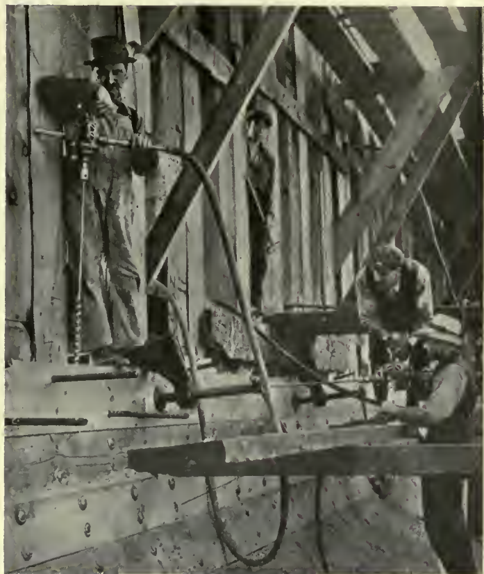
Fig. 43b. Edge Bolting Ceiling
