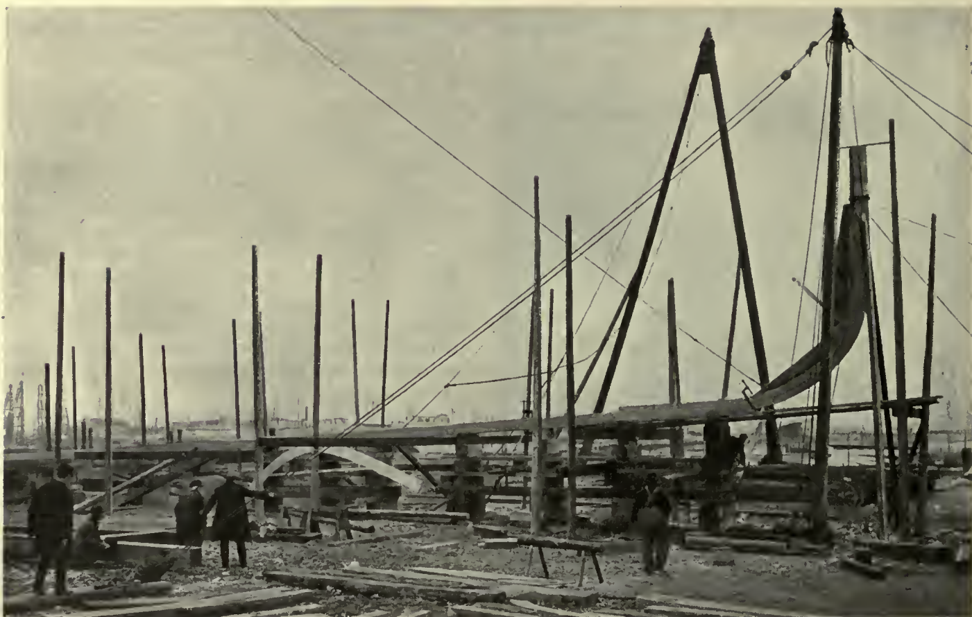
Fig. 30. Keel Set Up
