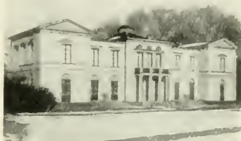
Rosendals slott. Södra fasaden.
