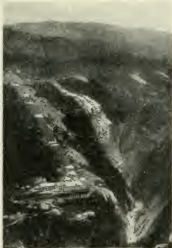
Övre kraftstationen vid Rjukan.
