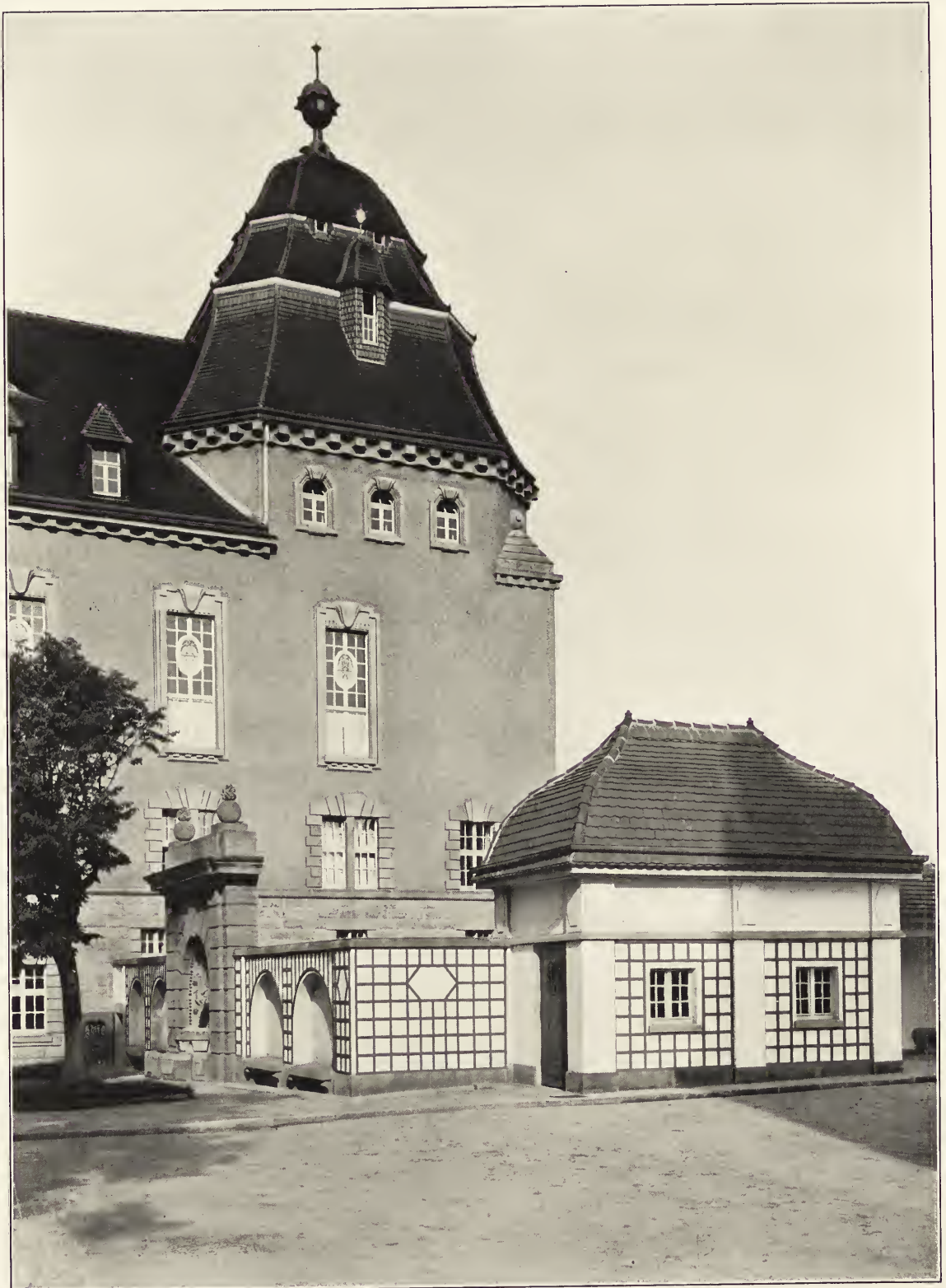
ARCHITEKTEN SCHILLING & GRAEBNER-DRESDEN in Gemeinschaft mit der kgl. Baudirektion, Oberbaurat Reh Neubauten des Sonnensteins bei Dresden: der neue Elbflügel nach der Elbe zu
