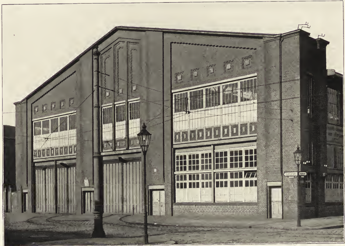
PROF. ALFRED GRENANDER-BERLIN Elektr. Hoch- und Untergrundbahn in Berlin: Wagenschuppen an der Warschauerbrücke
