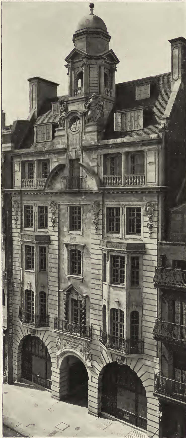
E. GUY DAWBER-LONDON Gebäude der London & Lancashire Feuerversicherungs-Gesellschaft, Pall Mall, London
