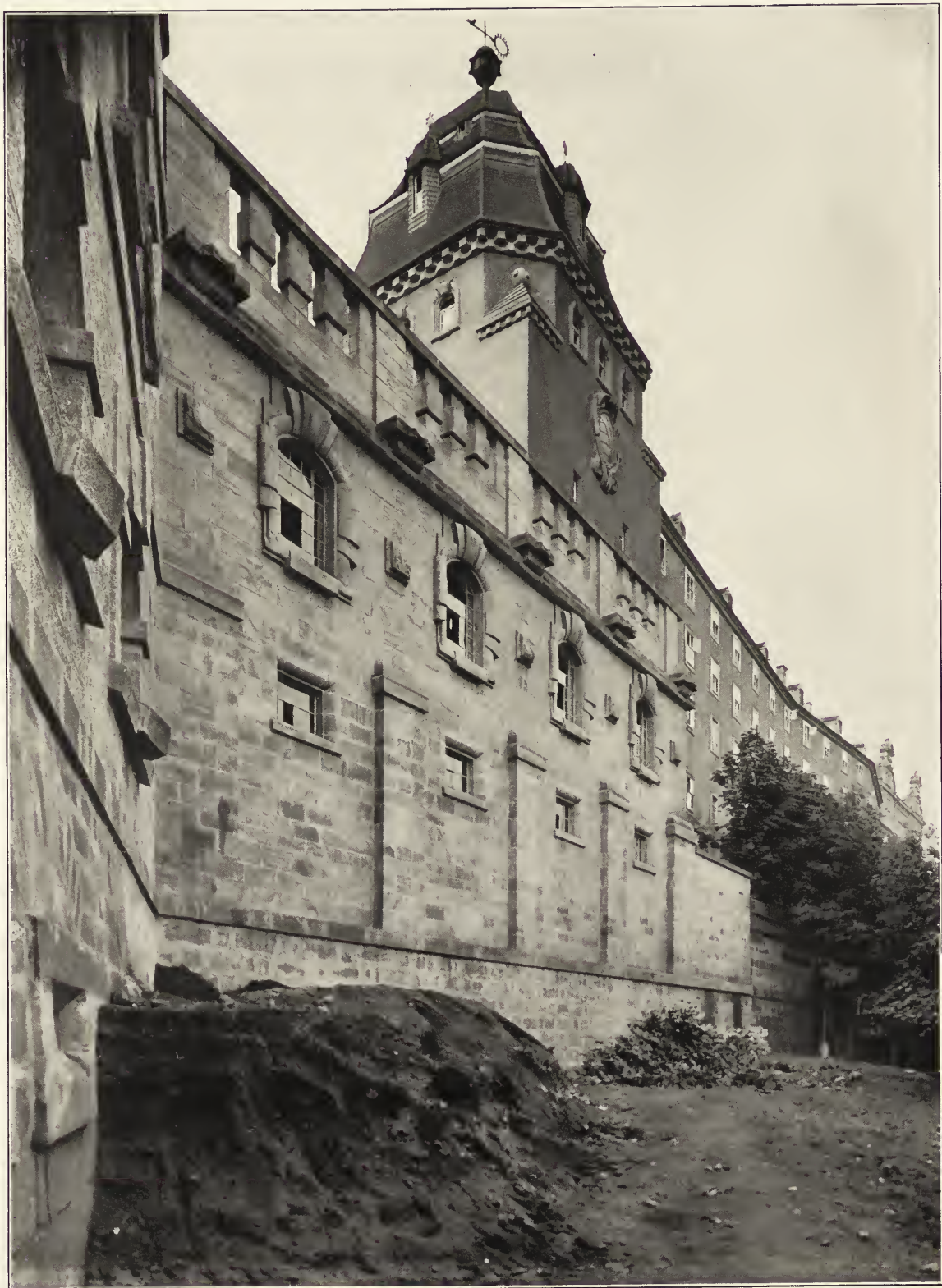
ARCHITEKTEN SCHILLING & GRAEBNER-DRESDEN in Gemeinschaft mit der kgl. Baudirektion, Oberbaurat Reh Neubauten des Sonnensteins bei Dresden: Aussenseite des Fernheizwerkes im Anschluss an die alte Festungsmauer
