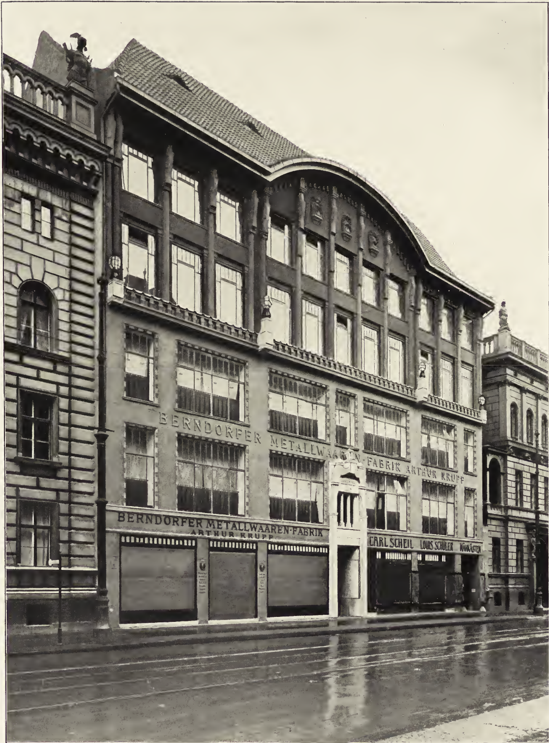
EMIL SCHAUDT-BERLIN Gebäude der Berndorfer Metallwarenfabrik in Berlin
