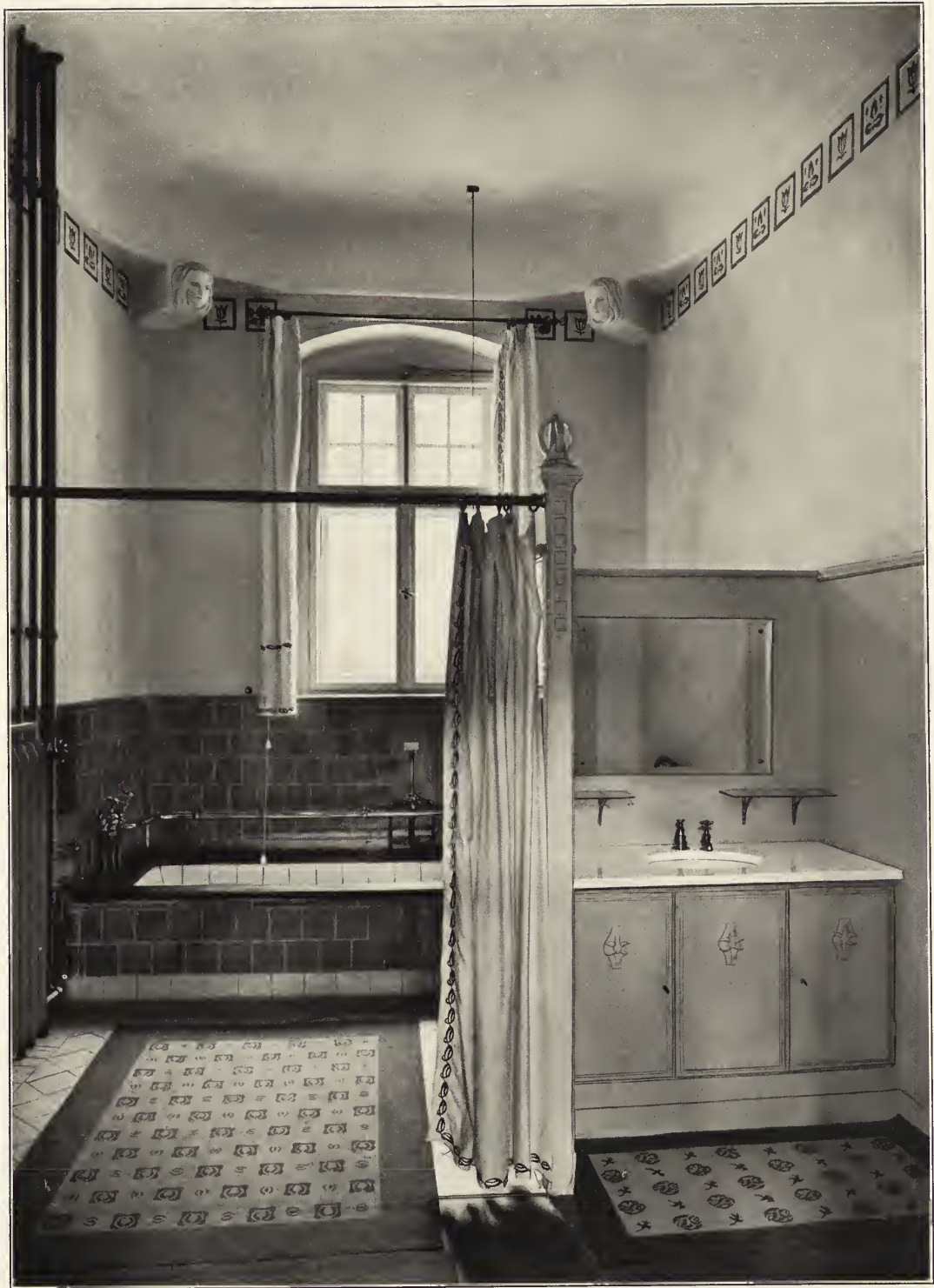
ARCHITEKTEN SCHILLING & GRAEBNER-DRESDEN in Gemeinschaft mit der kgl. Baudirektion, Oberbaurat Reh Bad Elster: einfache Moorbadezelle
