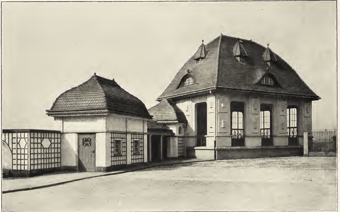
ARCHITEKTEN SCHILLING & GRAEBNER-DRESDEN in Gemeinschaft mit der kgl. Baudirektion, Oberbaurat Reh Neubauten des Sonnensteins: Eingang zum Fernheizwerk und Bastionspavillon vom Hofe aus
