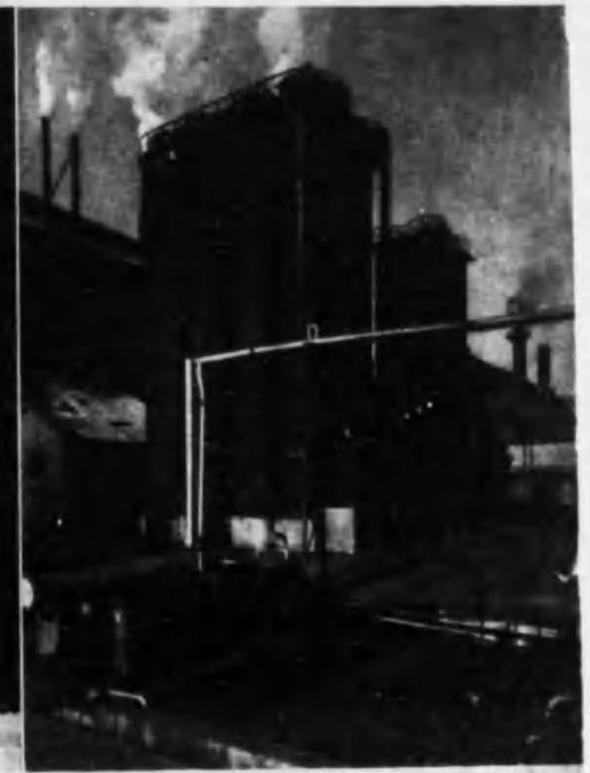
朝鮮窒素永安工場タール洗滌塔
