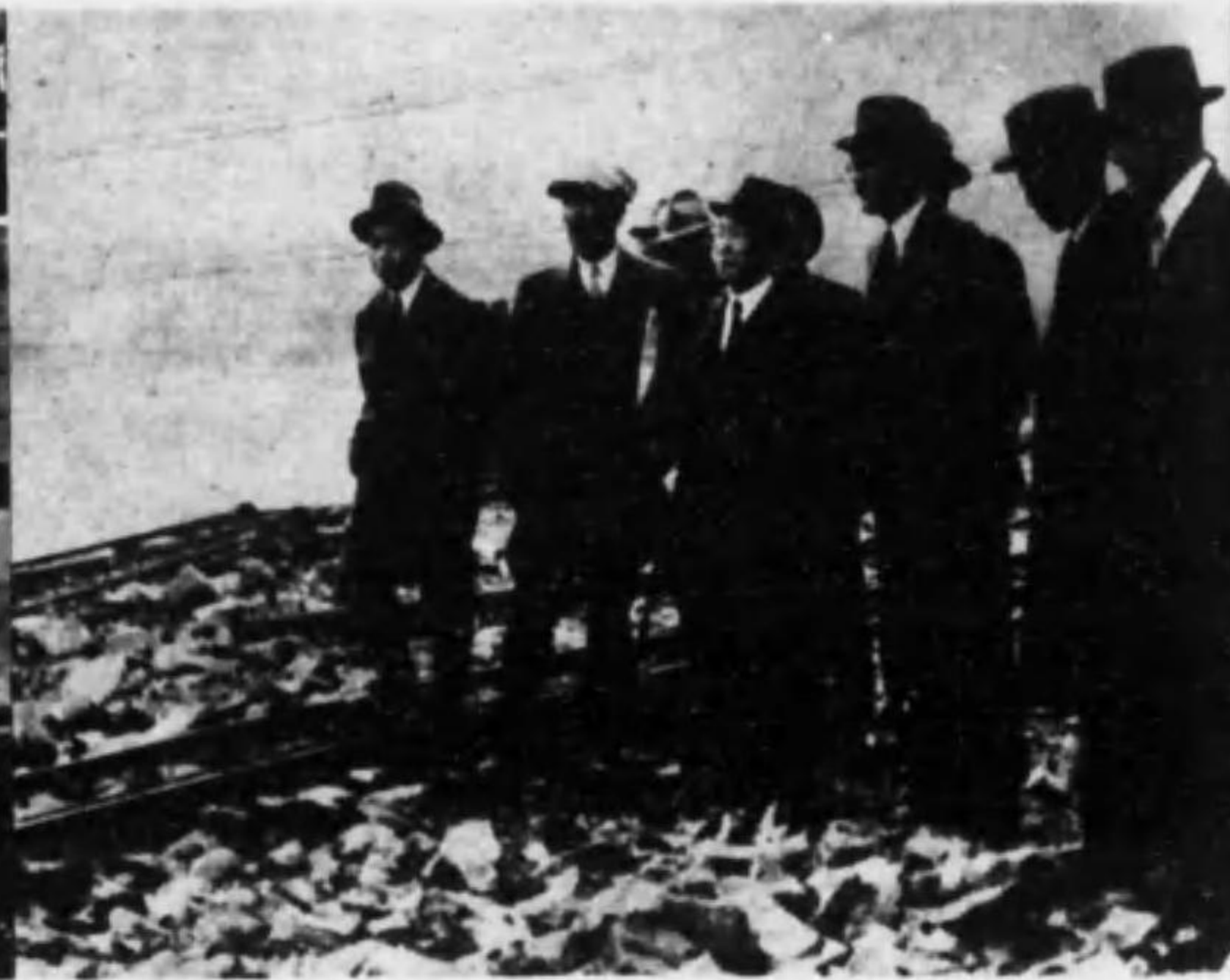
鴨綠江水電水壩堰堤工事場に於ける 野口社長及び其の一行——昭和14年
