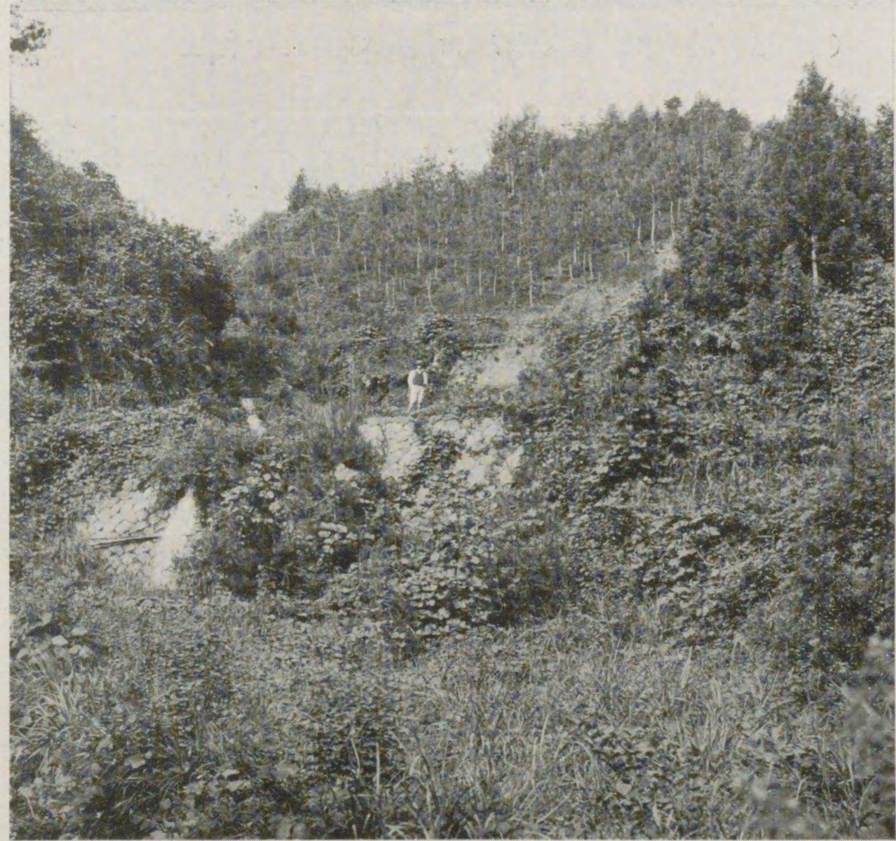
下新川郡南保村白鷺外六字森林組合地區内に於ける 大崩壞地復舊工事施工後十七年目の狀況
