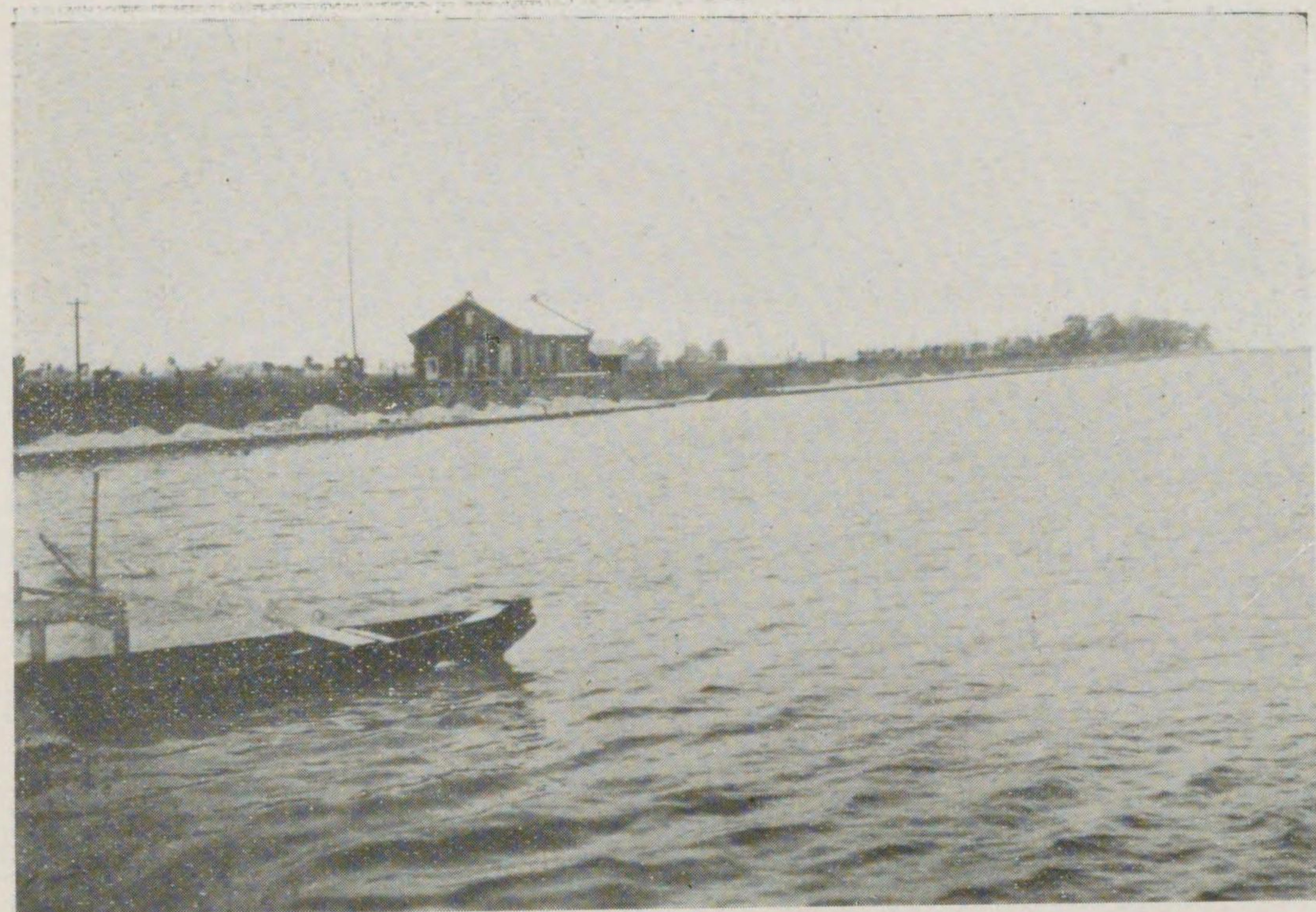
放生津防波堤及勘兵衛川排水場の遠景
