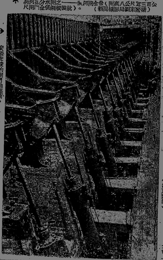
↑ 黃河分水閘之一——閘門全架(閘高八公尺寬三百公尺閘門全係鋼板製就)。(新聞攝影局劉東察攝)
