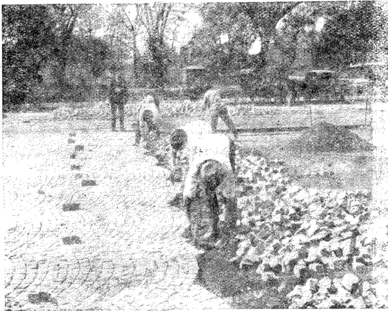
第 97 圖 立方石塊之施工
