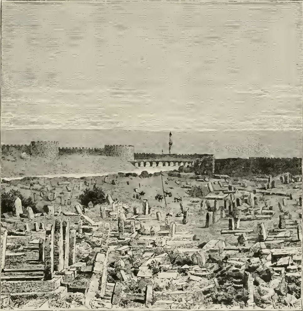
Fig. 82.—DIARBEKIR—BRIDGE OVER THE TIGRIS.
