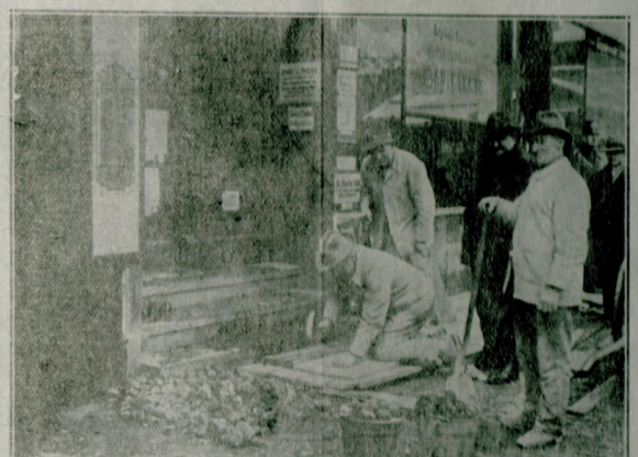
Ouvriers obstruant une bouche d'aération communiquant avec le sous-sol de la banque et le tunnel paré par les cambrioleurs.
