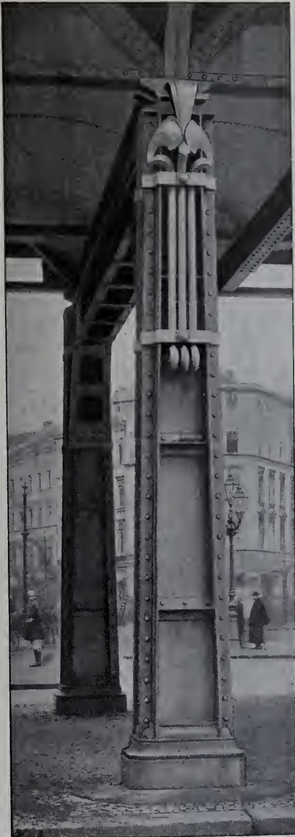
Stützen und Pfeiler der electricischen Hoch- und Untergrundbahn in Berlin. 2. An der Dresdener Strafe. Architekt: A. Grenander.
