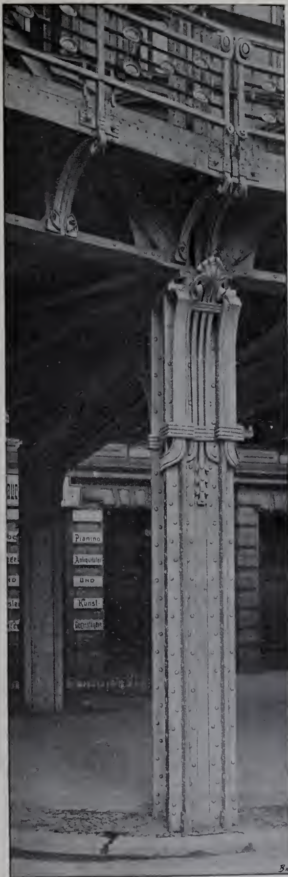
Stützen und Pfeiler der elektrischen Hoch- und Untergrundbahn in Berlin. 5. An der Lutherkirche. Architekt: Bruno Möhring.
