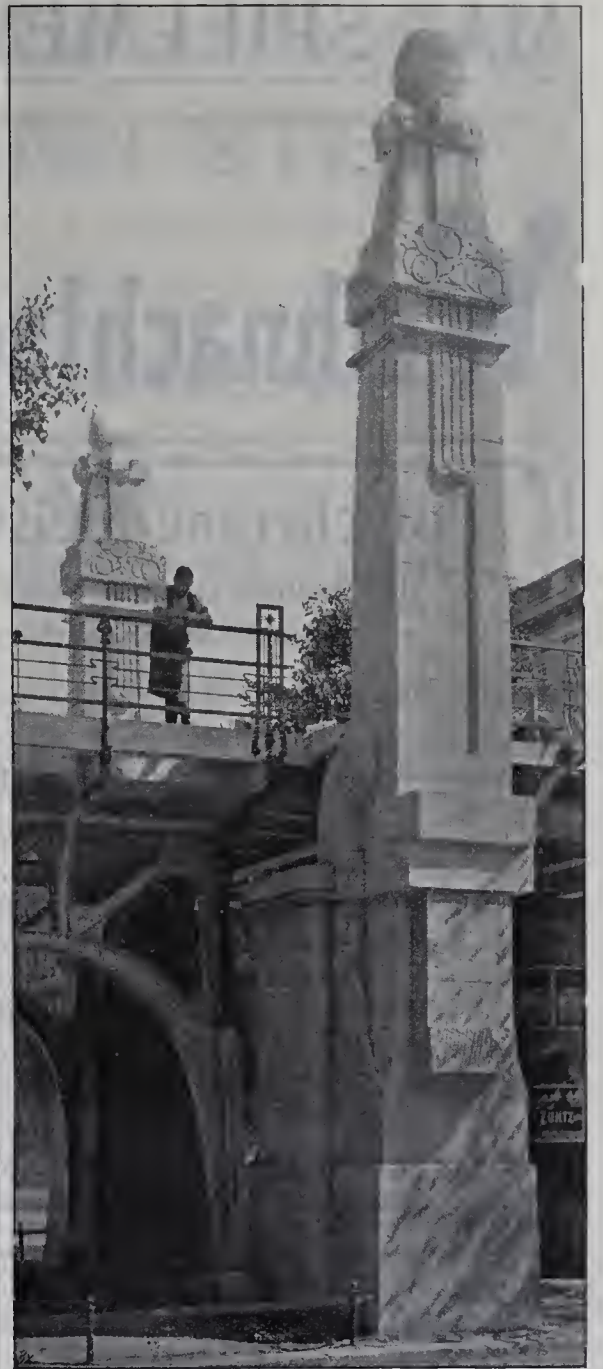
Stützen und Pfeiler der elektrischen Hoch- und Untergrundbahn in Berlin.
