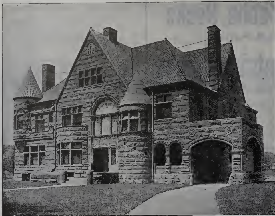
Wohnhaus Alb. L. Stephens a. d. Woodward-Avenue in Detroit. Architekten: Mason u. Rice. Erbaut 1890—1891. Stark verkleinerte Nachbildung aus Neubauten in Nordamerika.
