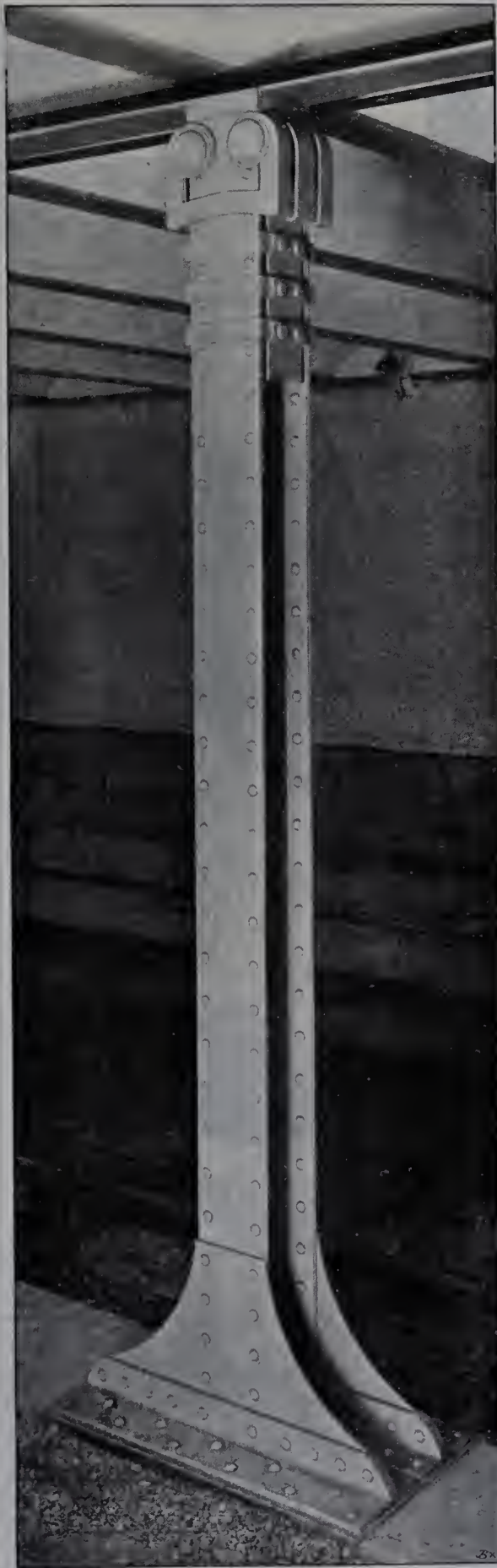
Stützen und Pfeiler der elektrischen Hoch- und Untergrundbahn in Berlin. 8. Am Untergrundbahnhof am Wittenberg-Platz. Architekt: P. Wittig.
