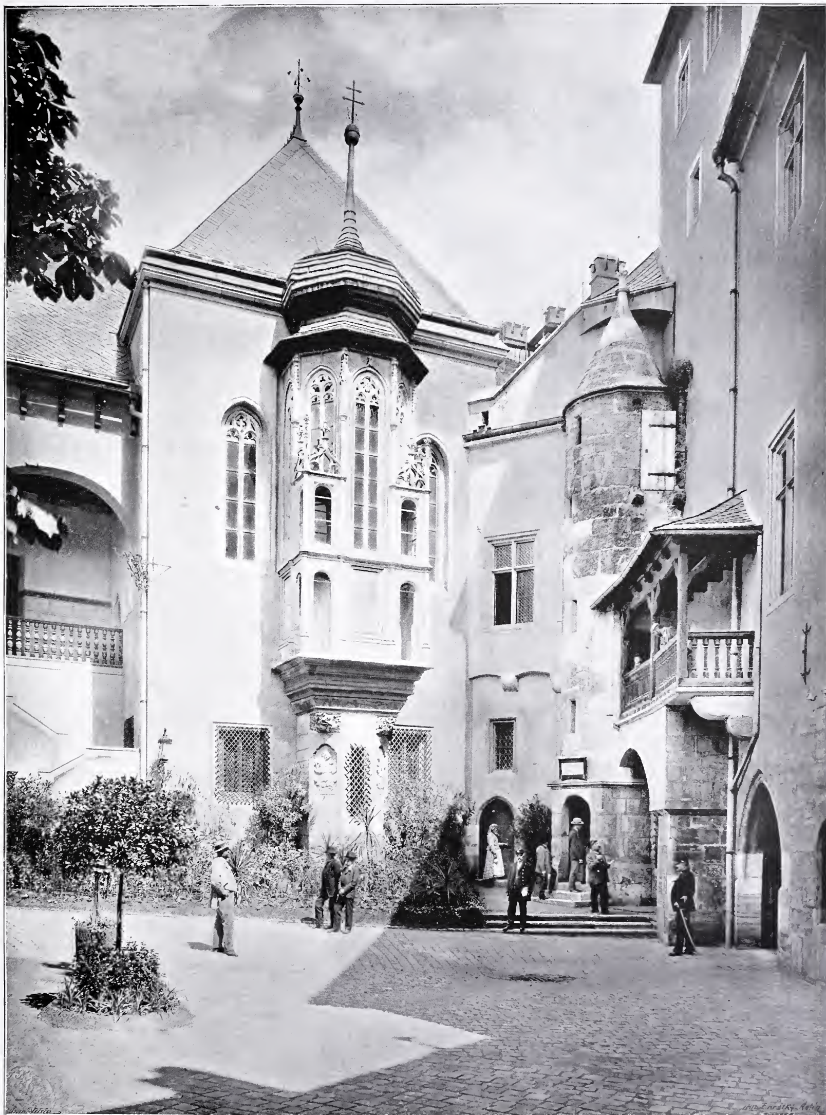
NÁDVOŘÍ VLAŠSKÉHO DVORA V HOŘE KUTNÉ PO OBNOVĚ.
