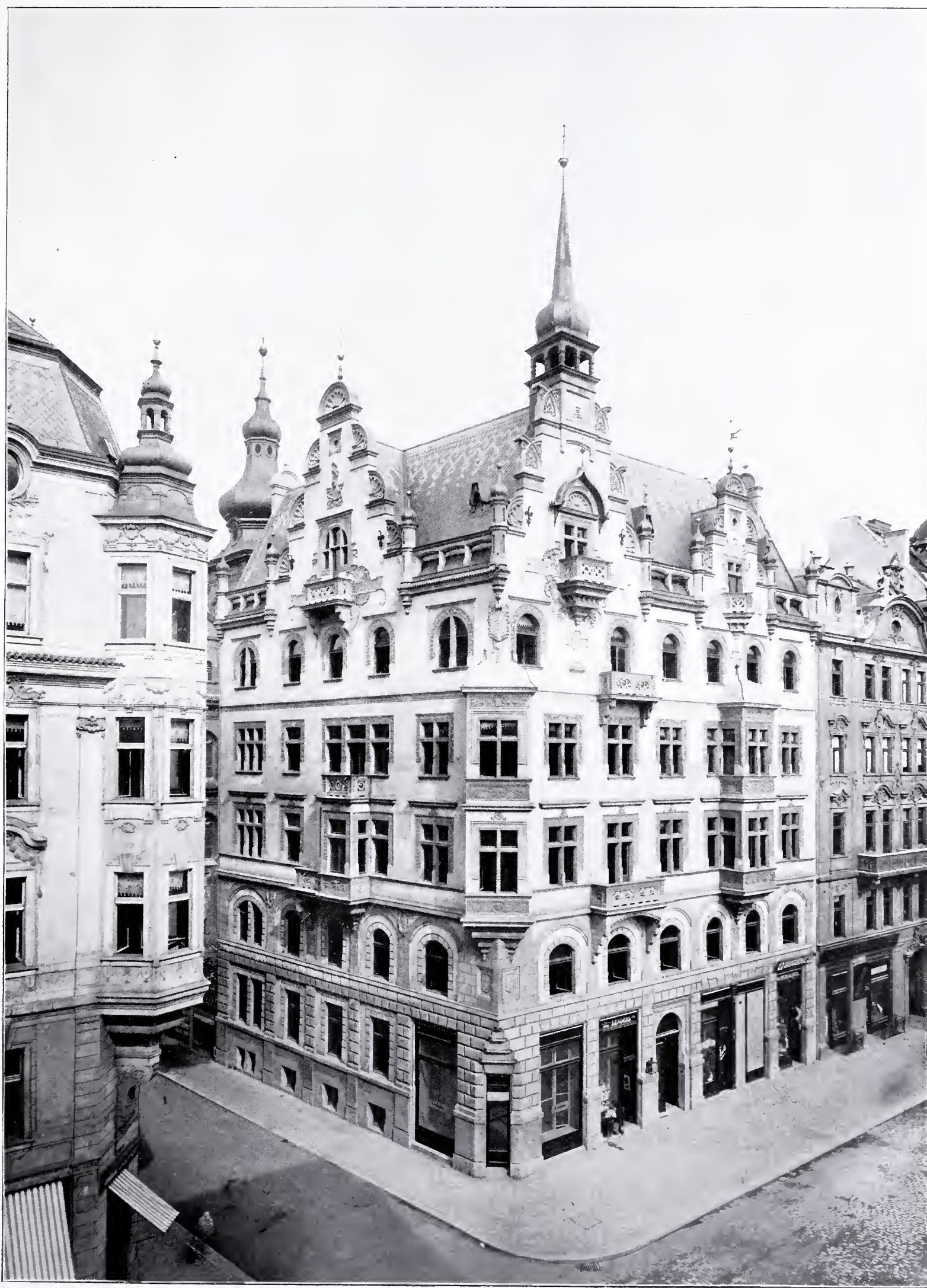
Arch. Jan Vejrych a stav. E. Dvořák: ČINŽOVNÍ DŮM Č. 1068-V. V MIKULÁŠSKÉ TŘIDĚ V PRAZE.
