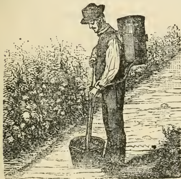
Fig. 46. — Remplissage du pulvérisateur l' Automatique .
