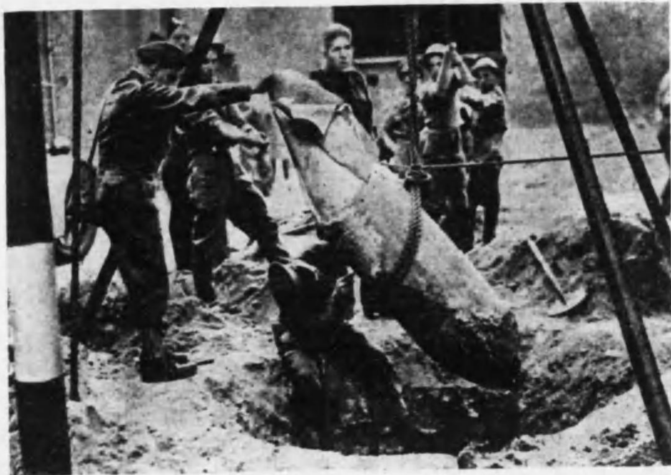
在倫敦逸病院内地に落下せる二百二十ポンドの計時爆弾(ムイタ) 在倫敦逸病院内地に落下せる二百二十ポンドの計時爆弾(ムイタ) 在倫敦逸病院内地に落下せる二百二十ポンドの計時爆弾(ムイタ)
