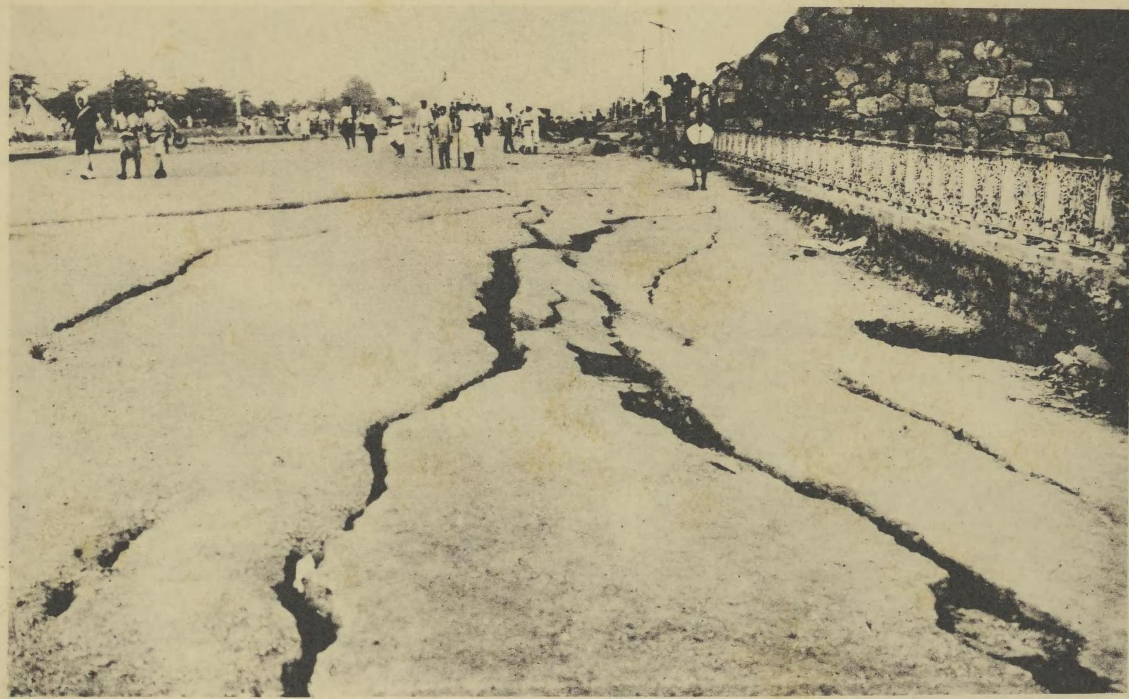
凱旋道路の龜裂
