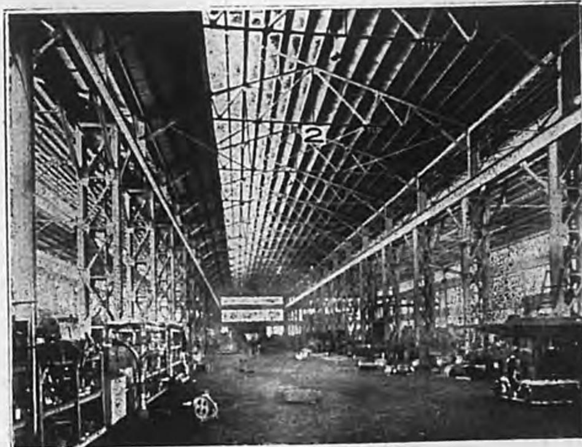
弊社設計施工 銀行工場建築例
