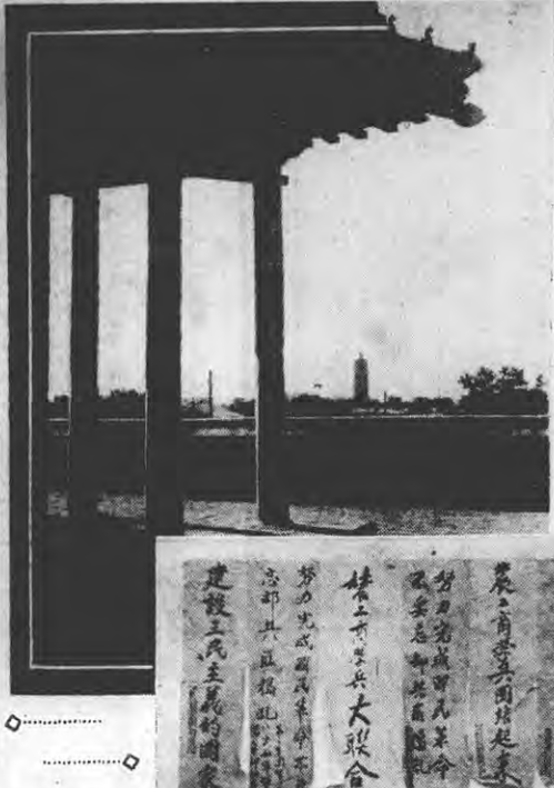
建設五區之進展
