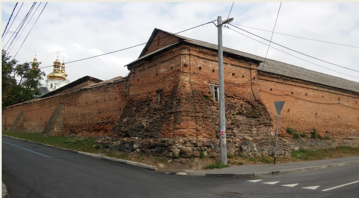
Башта вінницьких «Мурів» XVII–XVIII ст. – комплекс оборонних споруд Домініканського монастиря (фото автора)
