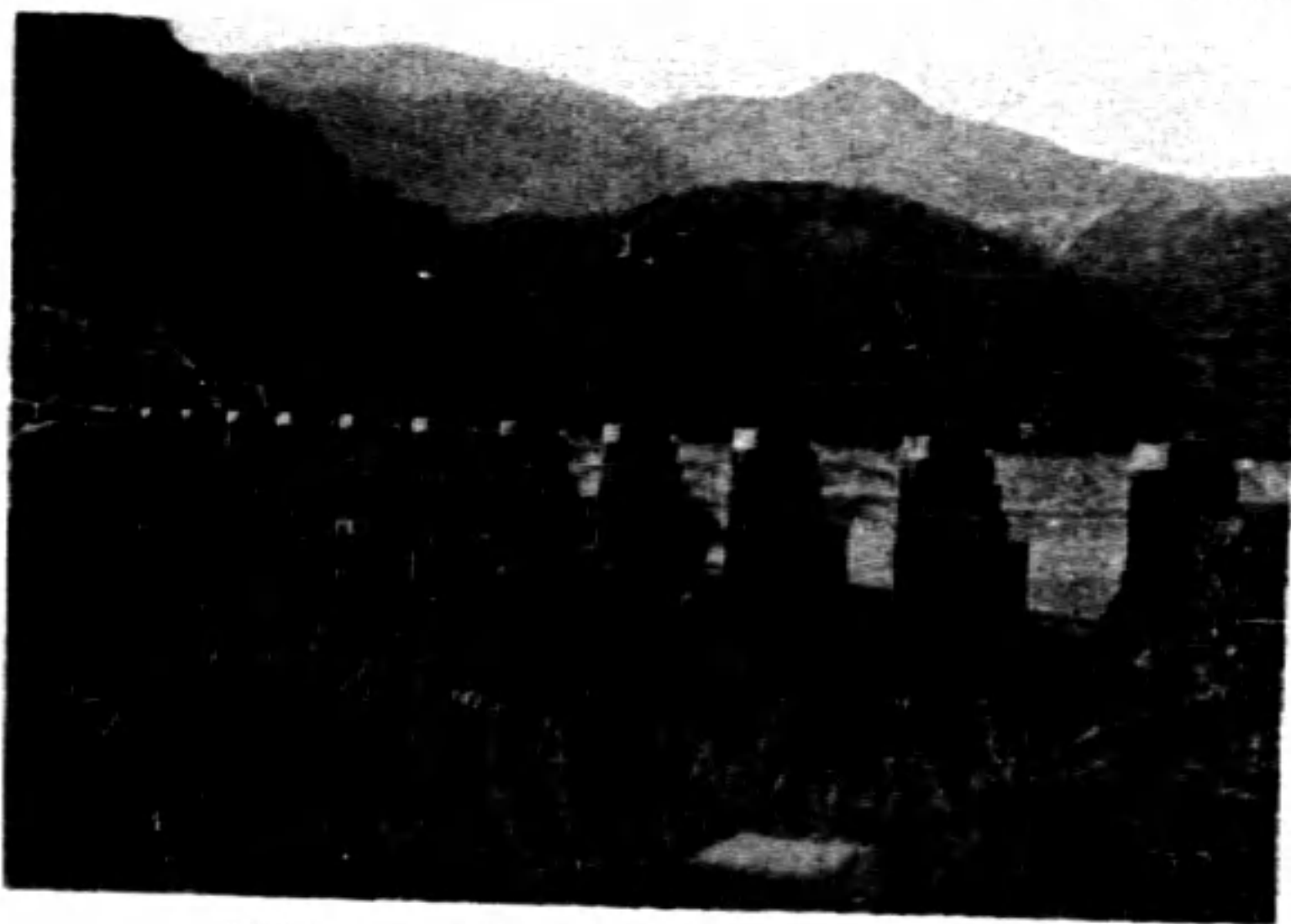
影(六) 大潭副池之洩水道 大潭池滿時水即由此外溢。洩水口上及橋墩旁 之槽，即預備加插木板，以增儲量者。
