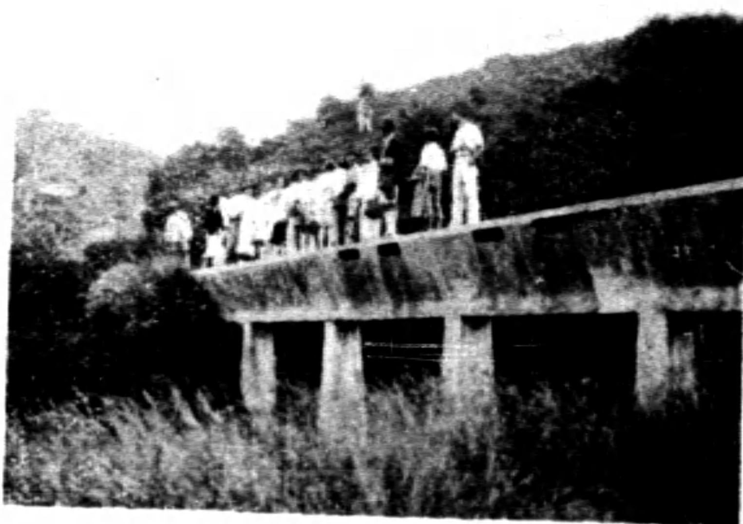
影(二十一) 橫過山坳之引水槽 此項引水槽為引水溝之一部分,下有柱,上有蓋,亦作橋用,旁有溢口,以備水滿時外溢。
