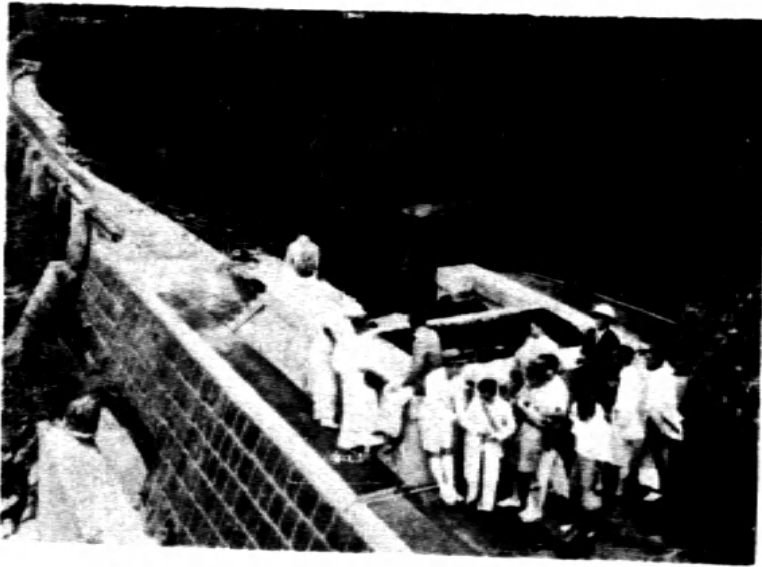
影(二十) 取水堤前之量水池 池有V字形量水口以量流量。由左上角蜿蜒而來者即引水溝。
