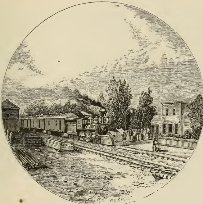
R. R. STATION, HUMBOLDT, NEVADA.
