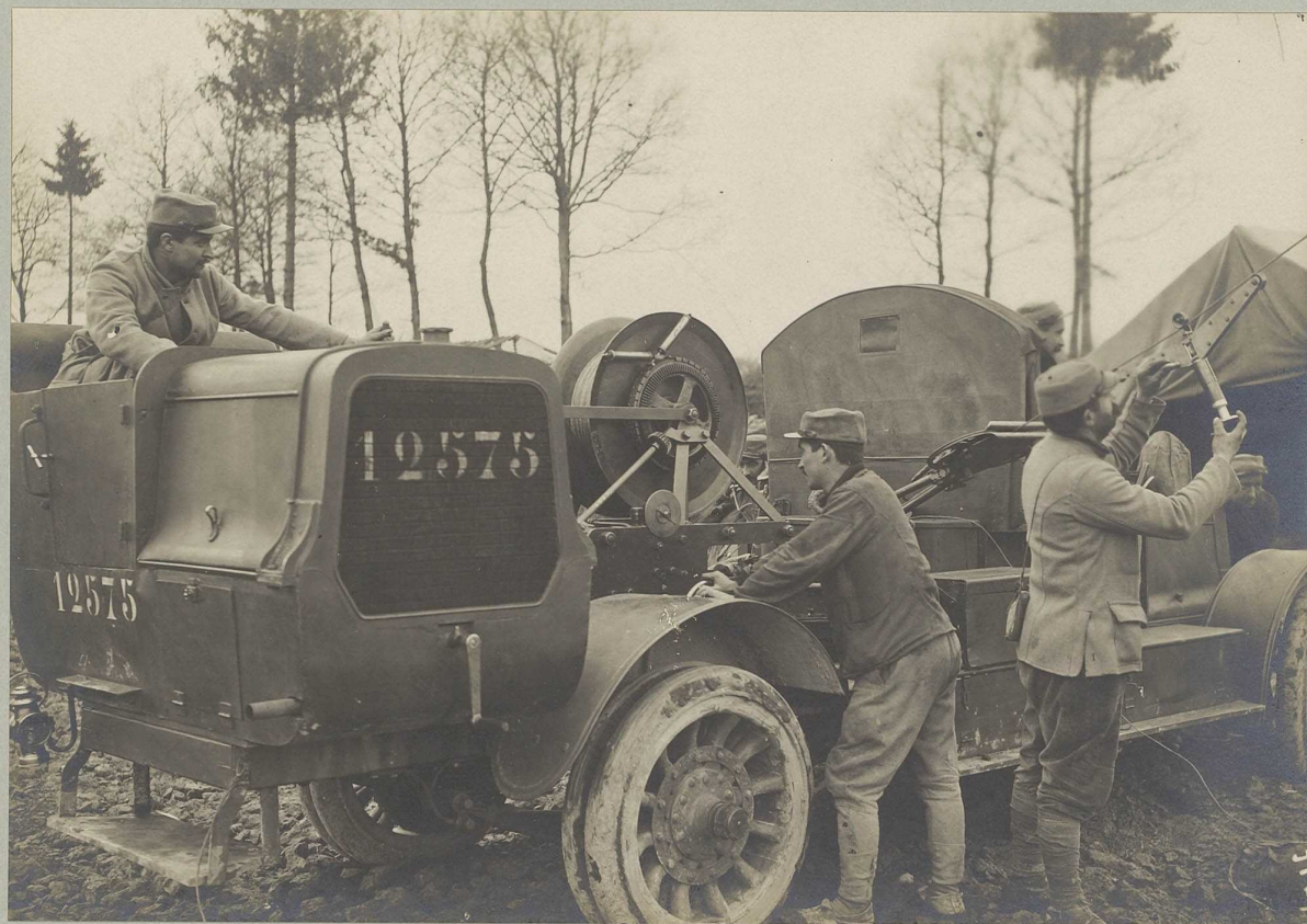
Treuil automobile d'un ballon d'observation. A dr. essai de la résistance du cable du ballon.
